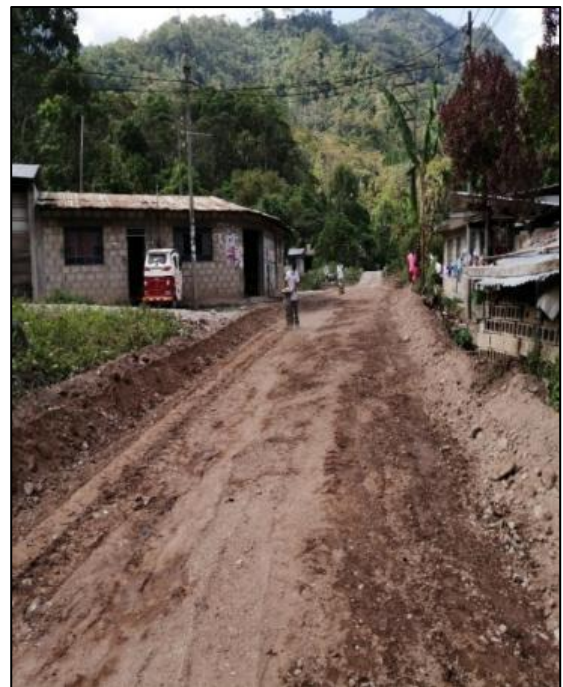
Fotografía 40. Proceso de compactación mecánica con vibro apisonador
