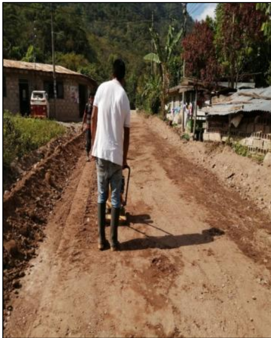
Fotografía 39. proceso de Compactación con plancha mecánica
