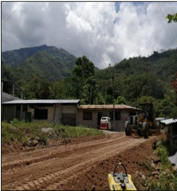
Fotografía 30. Corte terreno a nivel de Subrasante-vista 01
