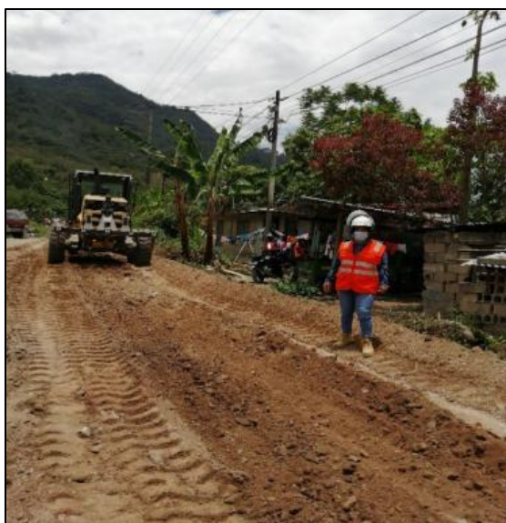
Fotografía 32: Trabajo de perfil estratigráfico
