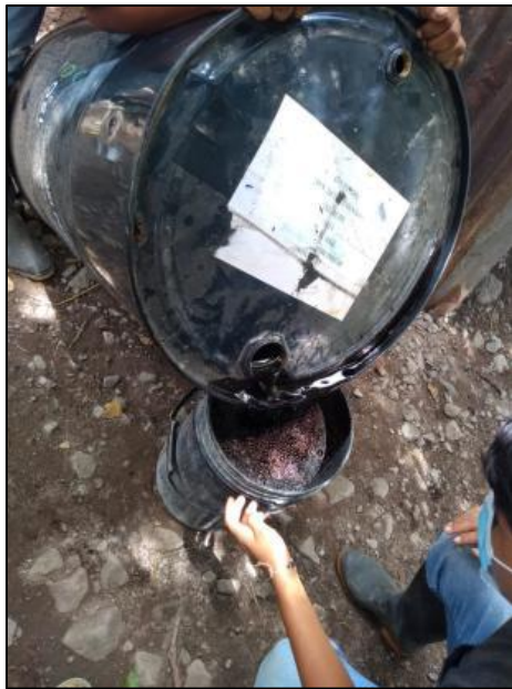
Fotografía 33. Dosificación del Aditivo Neo Soil Dust.
