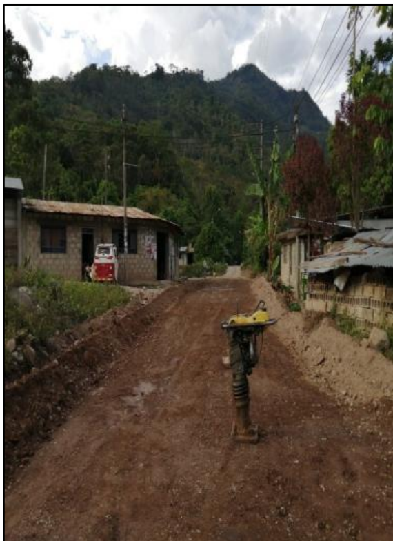
Fotografía 41. Final del procedimiento de la estabilización de suelos con el Aditivo Neo Soil Dust en el camino no pavimentado – Calle Pando.
