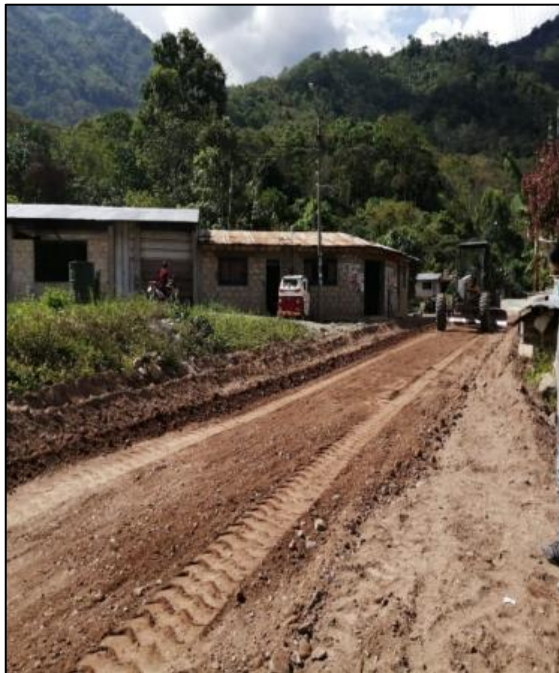
Fotografía 37. Batido del material a estabilizar muestra de 50 mt.
