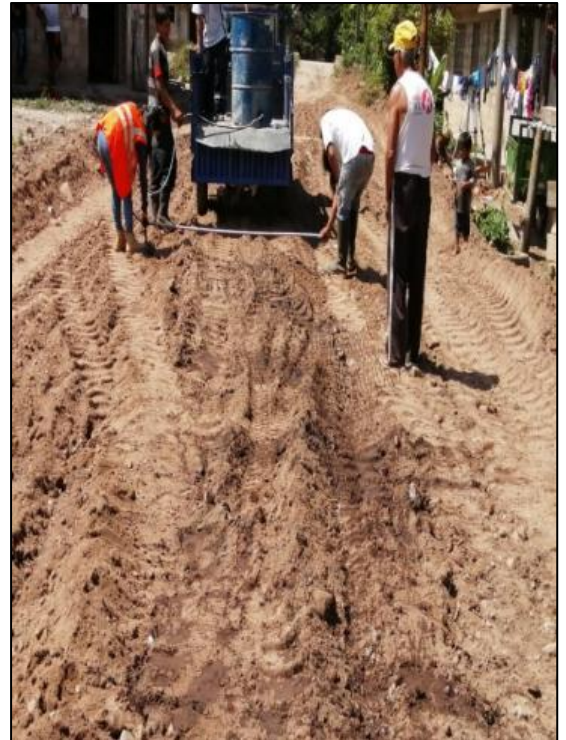
Fotografía 36. Aplicación del aditivo Neo Soil Dust.
