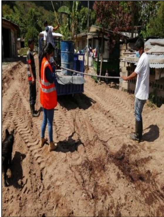
Fotografía 35. Aplicado del aditivo Neo Soil Dust
