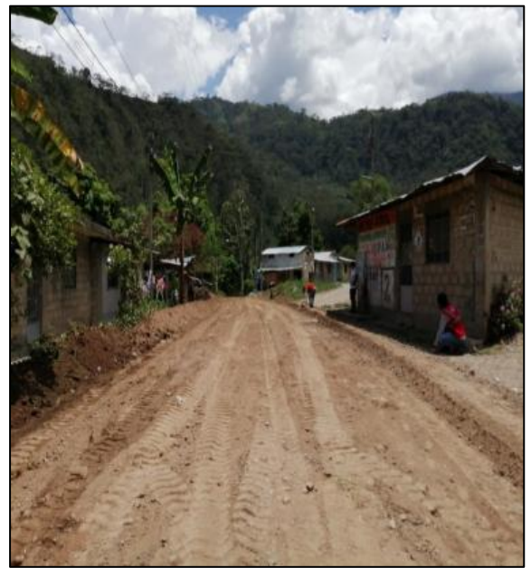
Fotografía 31. Corte de terreno a nivel de Subrasante, vista 02
