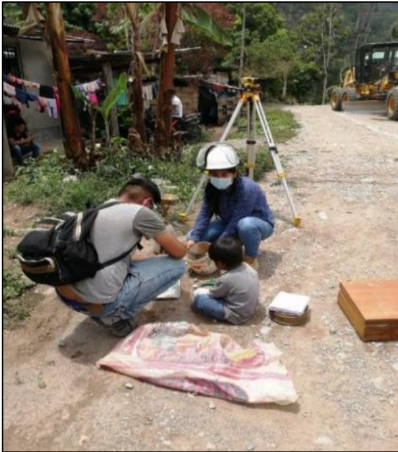
Fotografía 26. Ensayo de Densidad del suelo in situ
