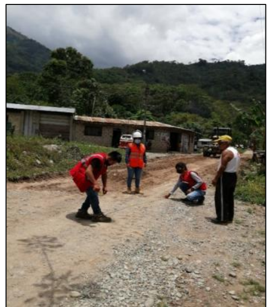
Fotografía 25. Toma de medida con flexómetro
