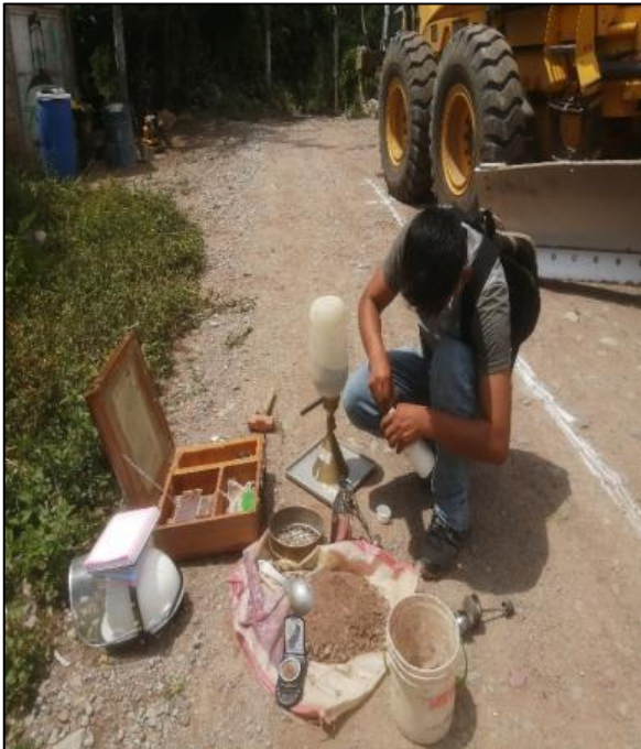
Fotografía 28. Equipos y materiales para el ensayo.
