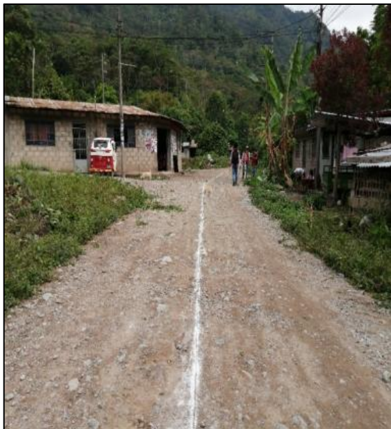
Fotografía 24. Trazo topográfico del camino no pavimentado
