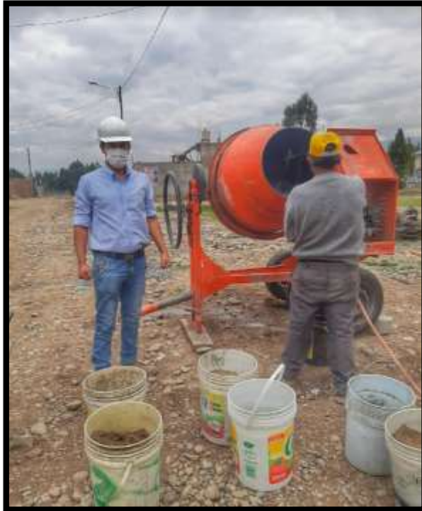
Figura: En la imagen superior se encuentra la mezcladora, ya que no se cuenta en la región una mezcladora de 3 velocidades para un volumen de 0.5 \text{ m}^3 por lo que se optó en utilizar la mezcladora tipo trompito.
