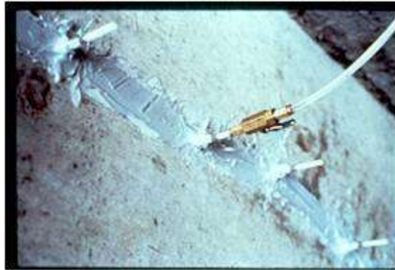
Figura 6: Aplicación de resina epóxica por el método de inyeccion
