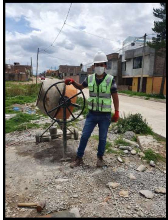
Figura: En la imagen superior se encuentra la mezcladora, ya que no se cuenta en la región una mezcladora de 3 velocidades para un volumen de 0.5 \text{ m}^3 por lo que se optó en utilizar la mezcladora tipo trompito.
