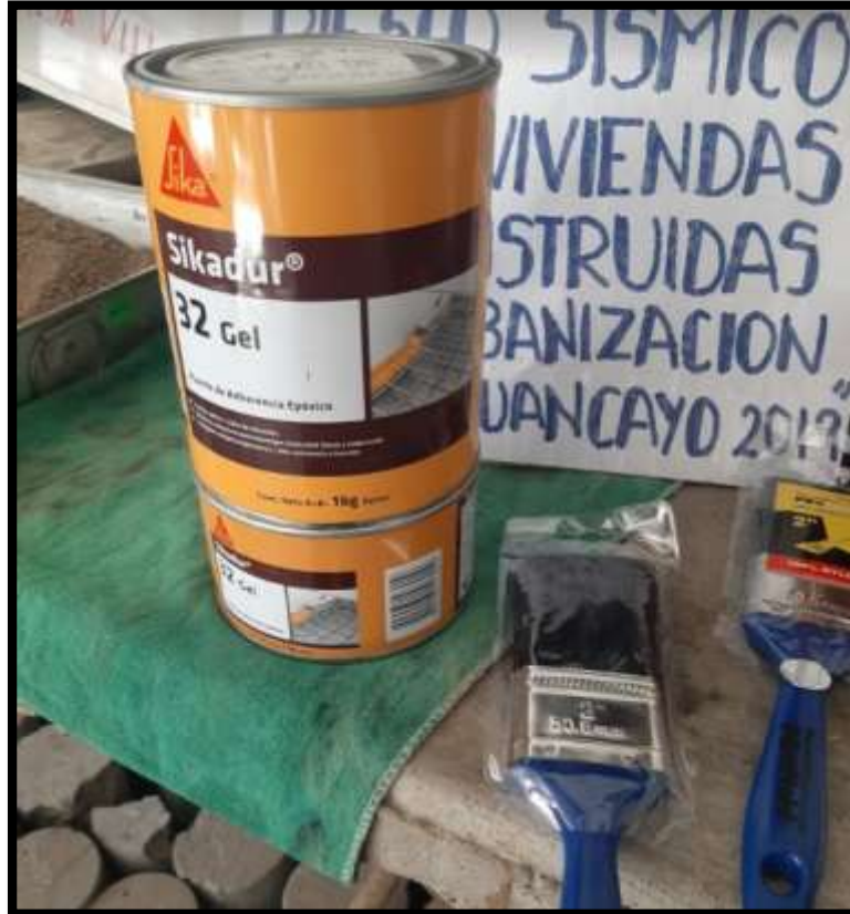
Figura: Después de un día se aplica la resina epoxica sikadur 32 para formar un puente de adherencia entre los morteros.
