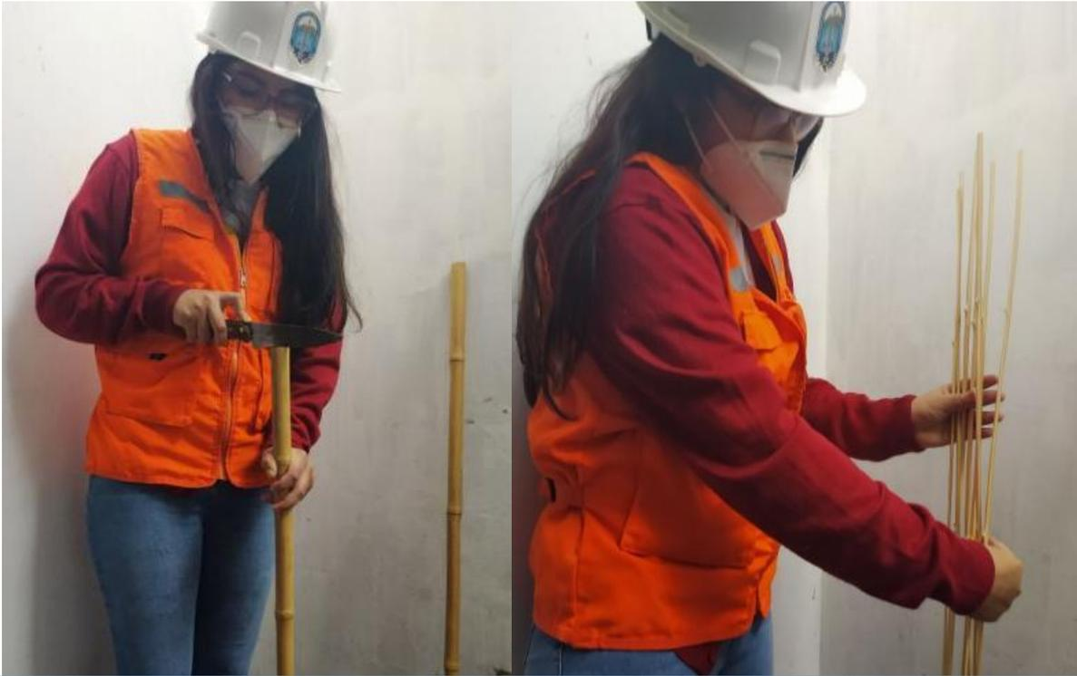
Se comenzó a cortar el bambú en tiras de 0.5cm de espesor para después elaborar la geomalla de bambú
