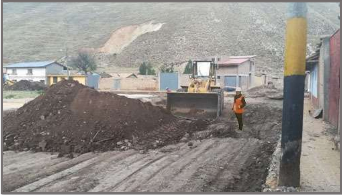
FOTO 19. Excavación en terreno normal.
