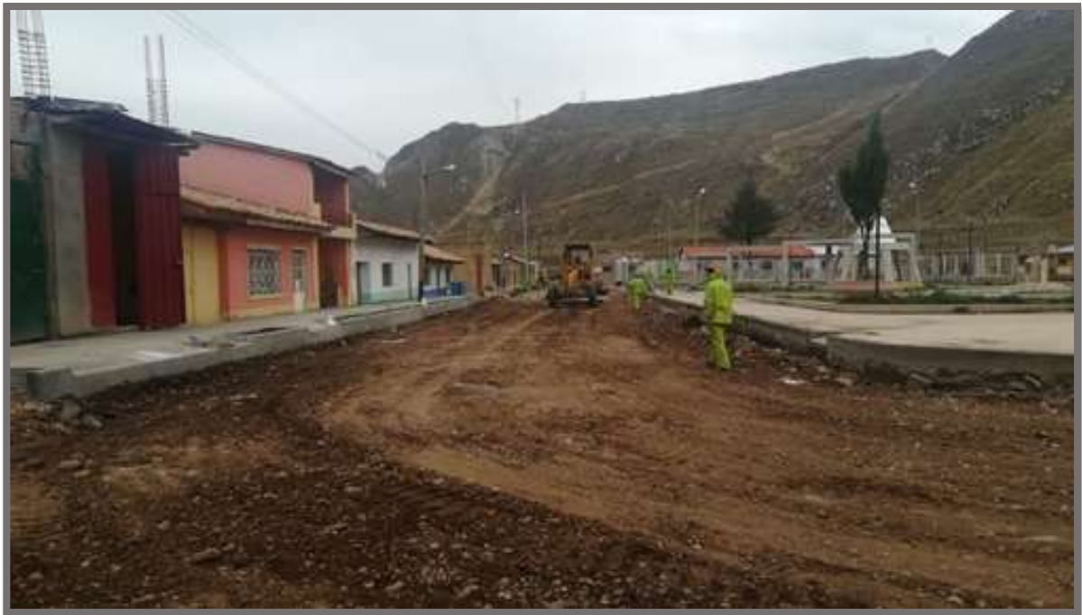
FOTO 22. Trabajos realizados con la motoniveladora.
