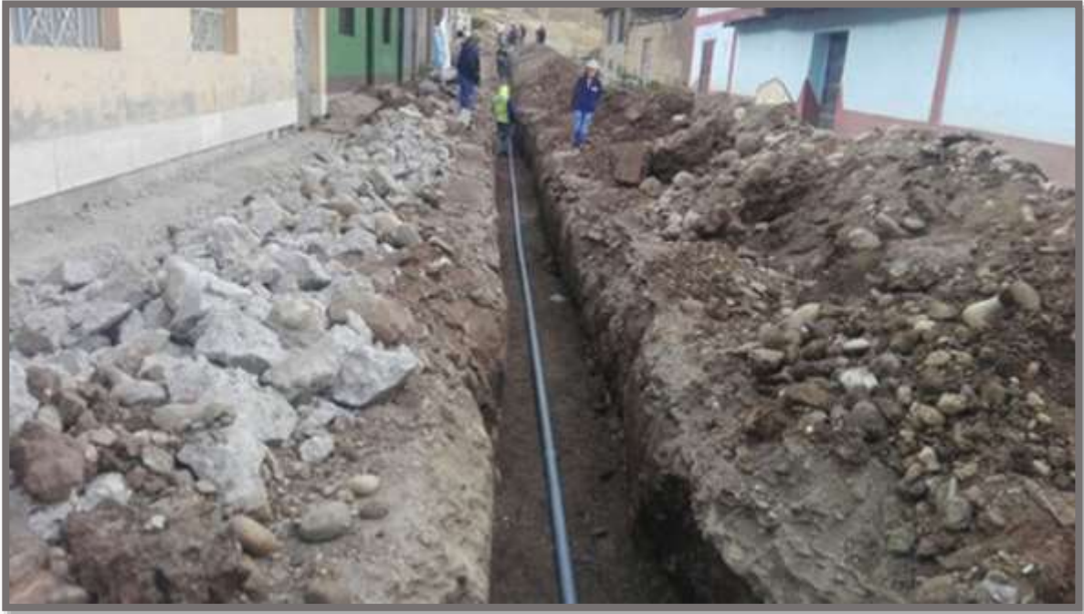
FOTO 21. Excavación para conexiones domiciliarias.
