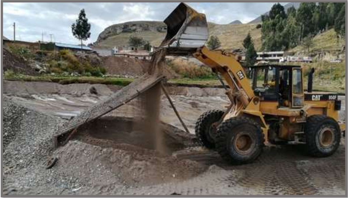
FOTO 17. Zarandeo de material propio para relleno y compactación.
