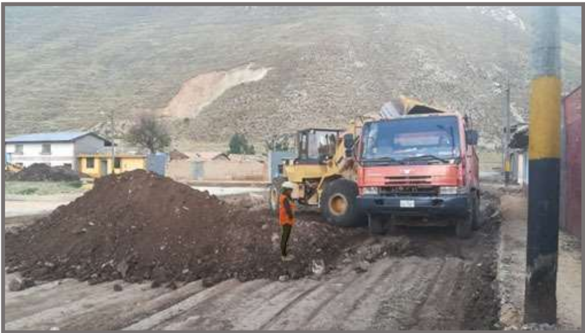
FOTO 16. Inicio de excavación en terreno normal en el Distrito de Curicaca.
