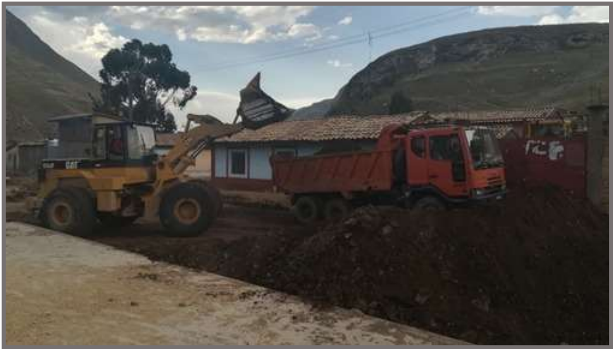
FOTO 20. Eliminación de material excedente
