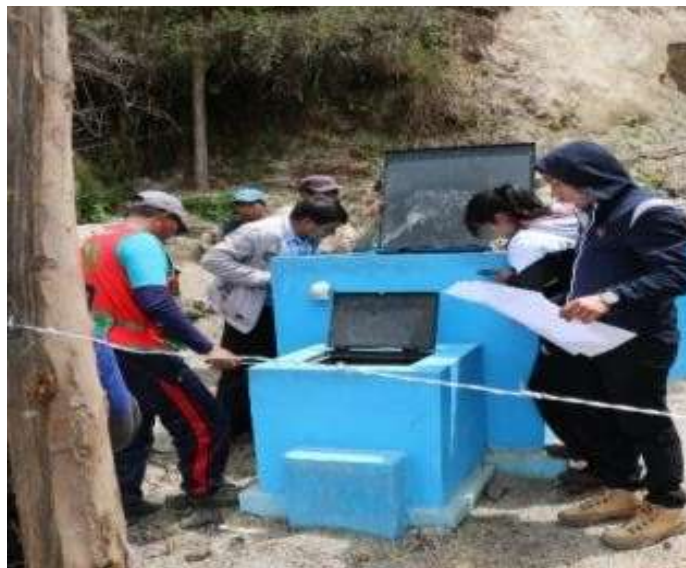
Fotografía 1 Visita a la captación
