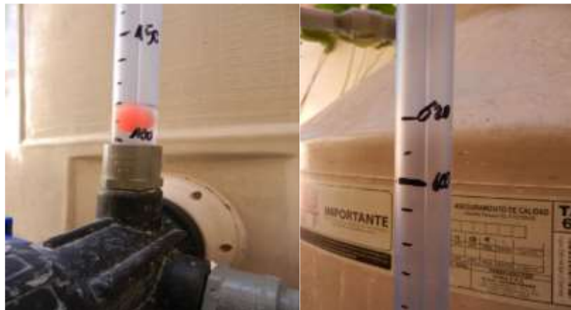
Figura 37 Vista de la demarcación
