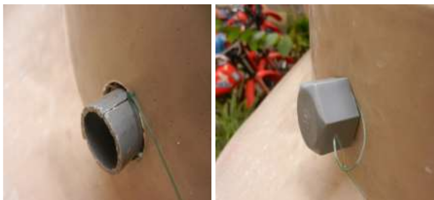
Figura 27 Vista del colocado del tubo de PVC SAP en el tanque.
