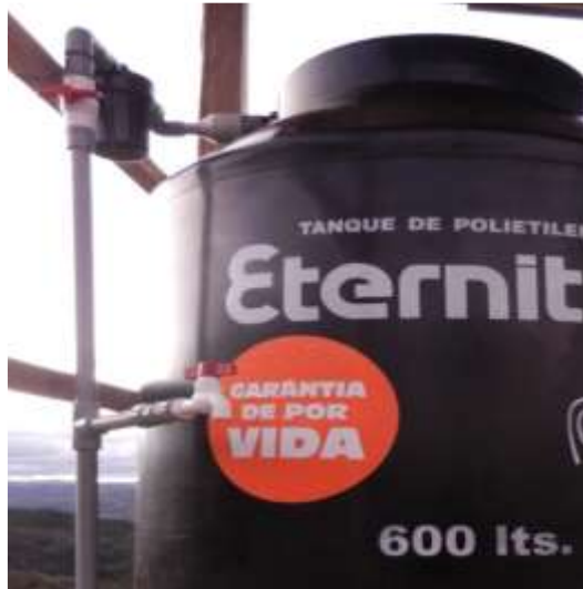
Figura 40 Vista del fijado de la tubería al tanque.
