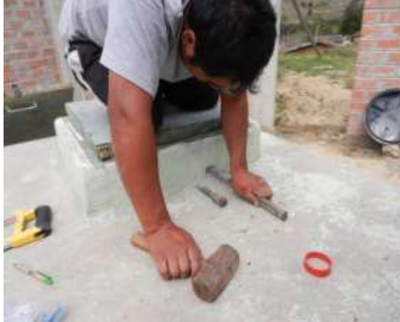
Figura 42 Vista habilitado para el ingreso de la tubería.
