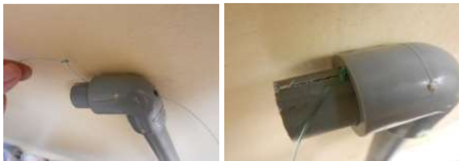
Figura 26 Vista del fijado de nylon en la ranura.
