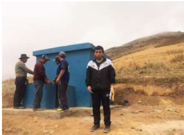
Fotografía 2 Visita al reservorio de 8 m3
