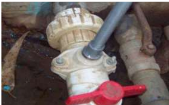
Figura 41 Vista de la instalación de la tubería
