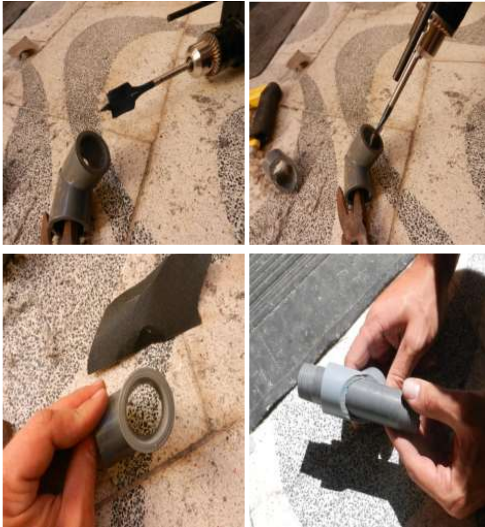
Figura 13 Vista del corte en diagonal el tubo tee.
