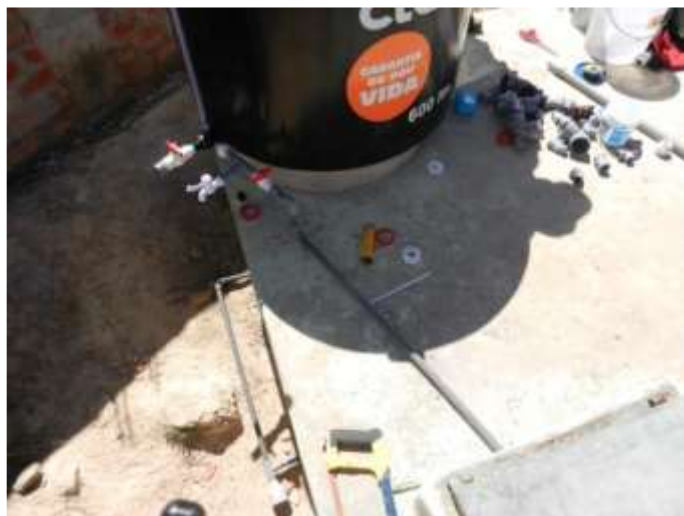
Figura 43 Vista de habilitado para el pase de la tubería.
