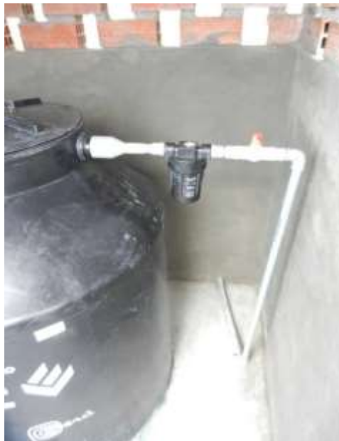
Figura 39 Vista del fijado de la tubería al tanque.
