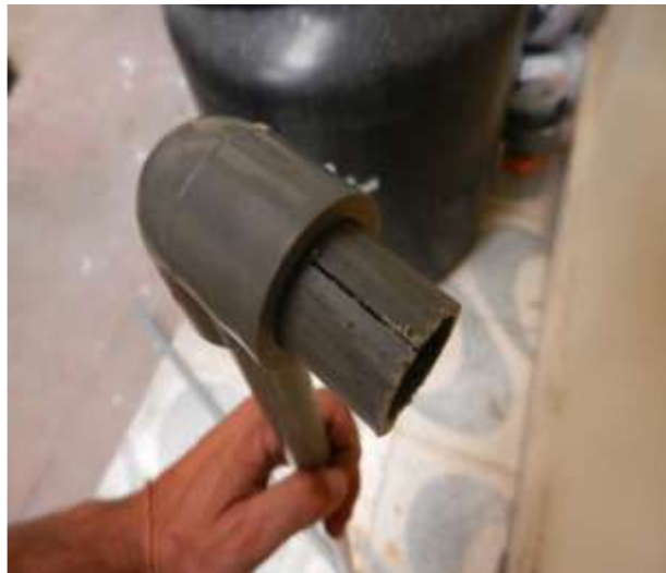
Figura 23 Vista de cortar un extremo del tubo a 4cm.
