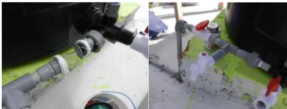
Figura 36 Vista colocado de la unión universal.
