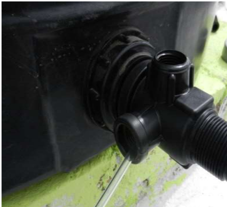
Figura 31 Vista de la instalación de las mangueras flexible por la salida lateral.
