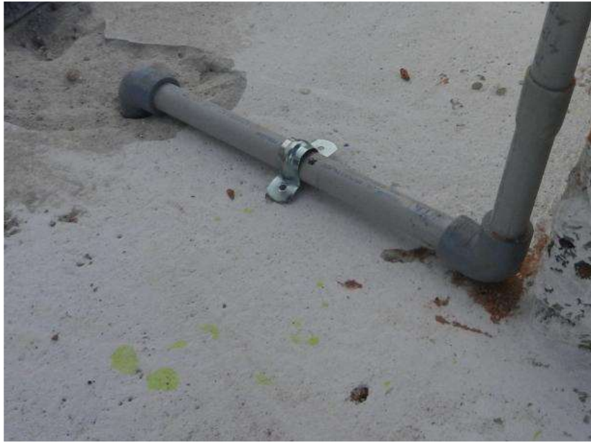
Figura 44 Vista del fijado del tubo de PVC de \Phi 1/2"
