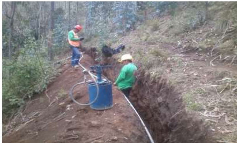
Fotografía 3 Vista del Tendido de Tubería
