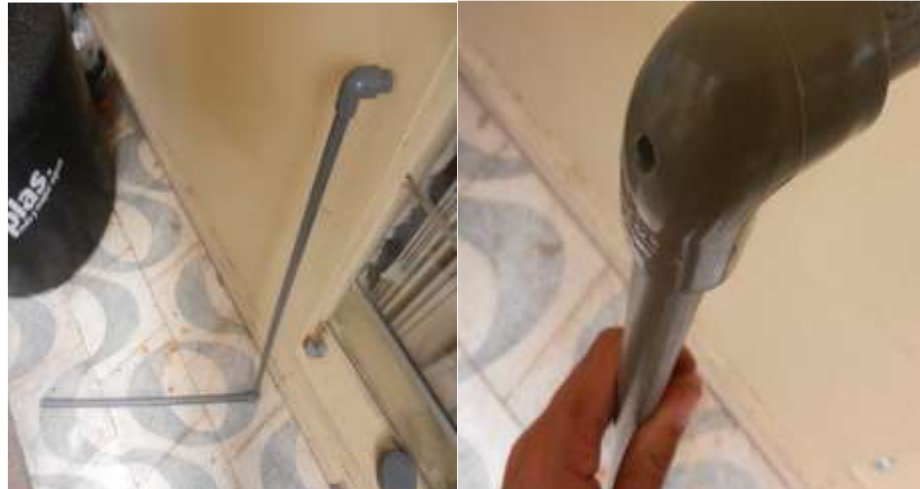
Figura 22 Vista de ensamblar los tubos de PVC de 1/2''
