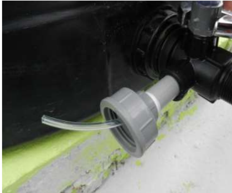
Figura 32 Vista del armado y pasar la manguera flexible a través del niple.
