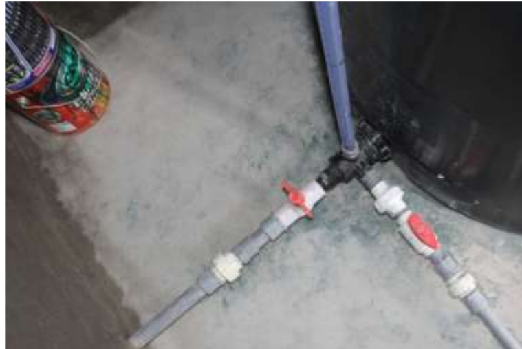
Figura 38 Vista de la instalación de la válvula de PVC SAP de \Phi 3/4 " y un adaptador de PVC SAP de \Phi 3/4 "
