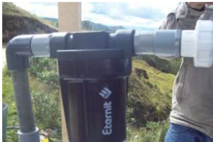
Figura 29 Vista de la instalación del filtro.
