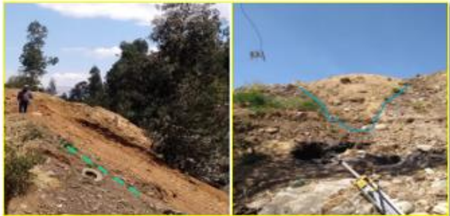
Fotografía 2: Deslizamiento de masa producto de los rellenos.
