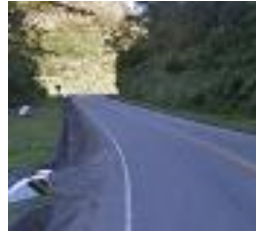
Foto 11. tangente por debajo del mínimo entre alineaciones de curva tramo V 8 2+300
