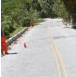
Foto 10. tangente por debajo del mínimo entre alineaciones de curva Tramo VI 82+300
