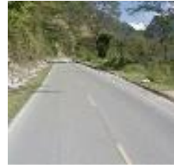
Foto 12. tangente por debajo del mínimo entre alineaciones de curva Tramo VI 91+500
