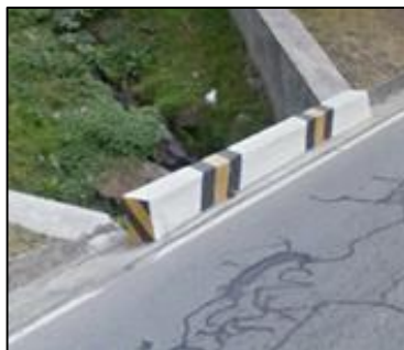
Figura 14: Alcantarilla en el 58+641
