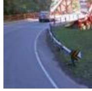
Foto 101. El ancho del puente es consistente con el ancho de calzada de la vía en el Km. 85+541
