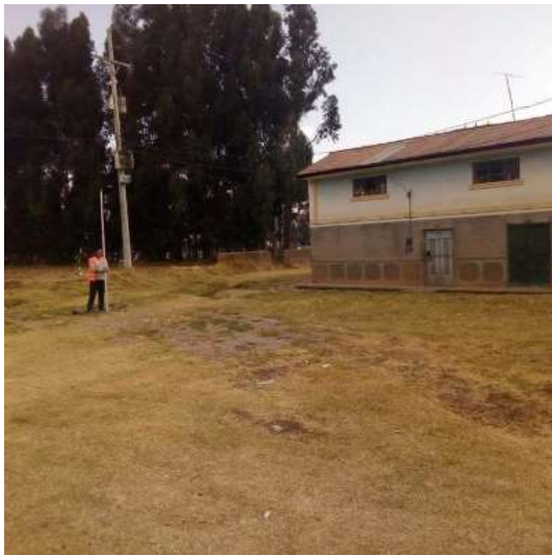
Levantamiento y replanteo topografico
