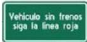
Figura 31. Señal informativa en la rampa de frenado.
