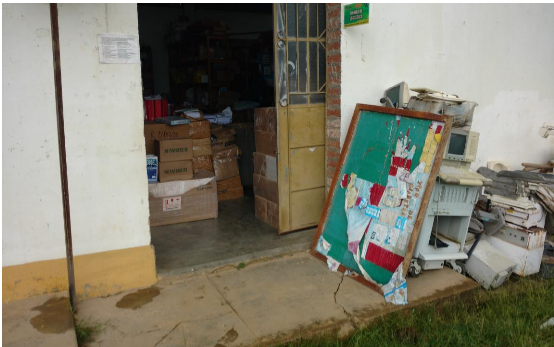
Almacén central de la Red de Salud Pangoa vista exterior
