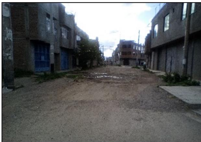
Figura 8- Estación de Control EP-1 - Jr. Alhelí (Jr. Agricultura).
