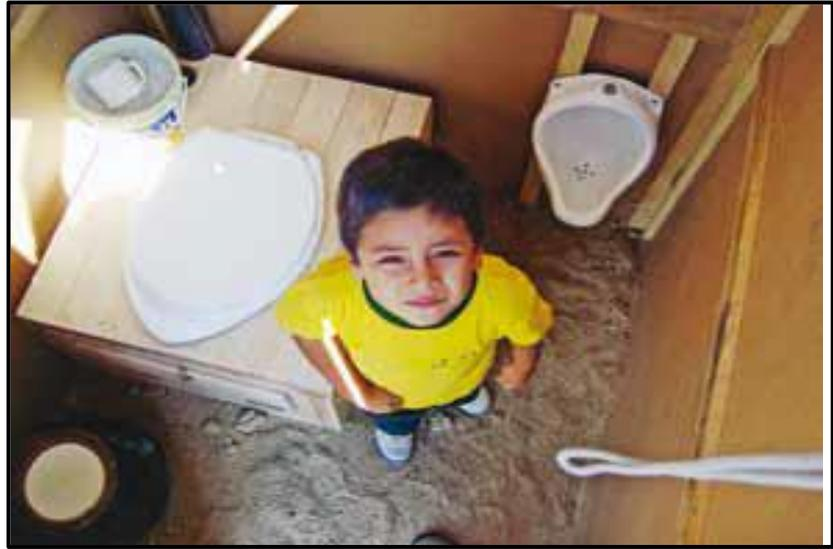
**Figura 5** Baño Ecológico seco con una sola cámara
