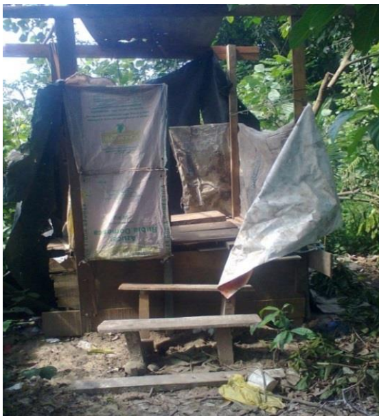
Figura 01. Estado actual de las letrinas en Villa Primavera
