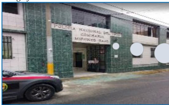
Fotografía 1: Fachada de la CPNP Mirones
