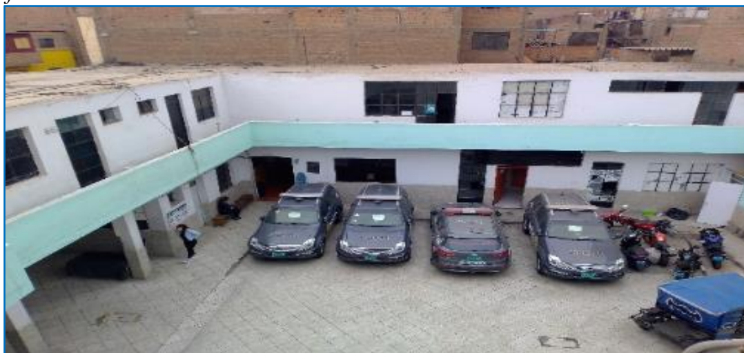
Fotografía 2: Vista de la estructura de la parte interior hacia la calle, en la cual se aprecia que la estructura es irregular en planta, por la configuración estructural en forma de U.
