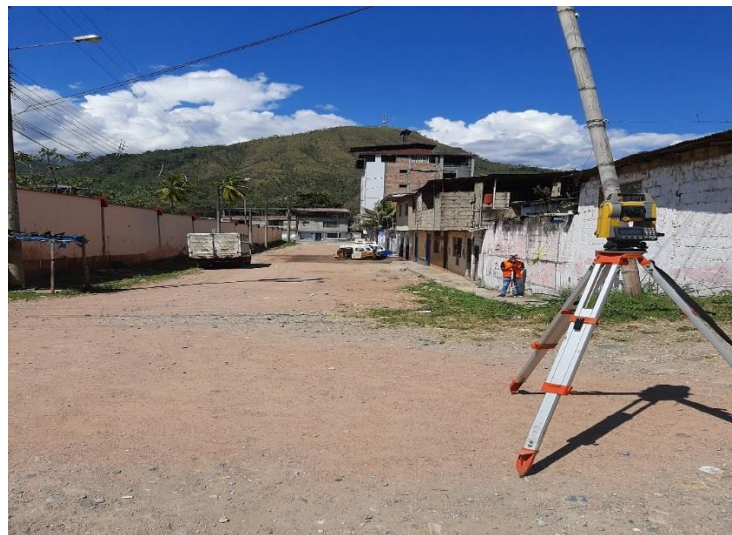
Figura 8- Inicio de trabajo en sector Huasahuasi.
