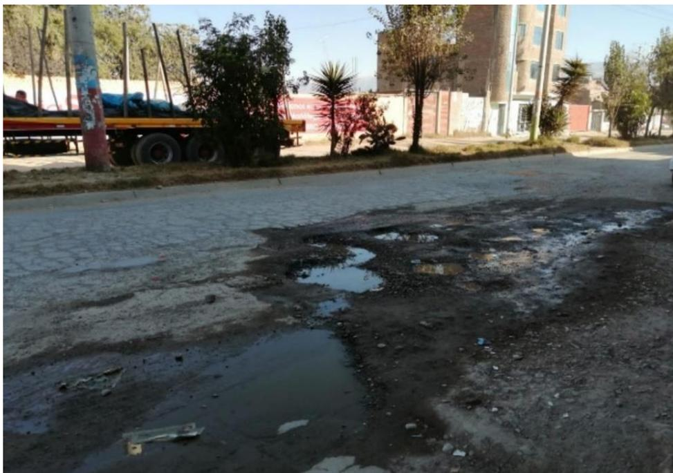
*Figura 3. Presencia de piel de cocodrilo en el pavimento Av. Los Próceres, Chilca*
