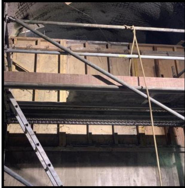
**Fotografía 14:** Vista fotográfica del vaciado de concreto en muro.
