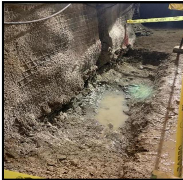
**Fotografía 7:** Vista fotográfica del vaciado de solado en zapatas.
