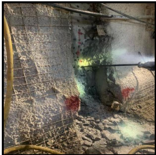
**Fotografía 5:** Vista fotográfica de la demolición de roca en hastiales para anclaje de muros.
