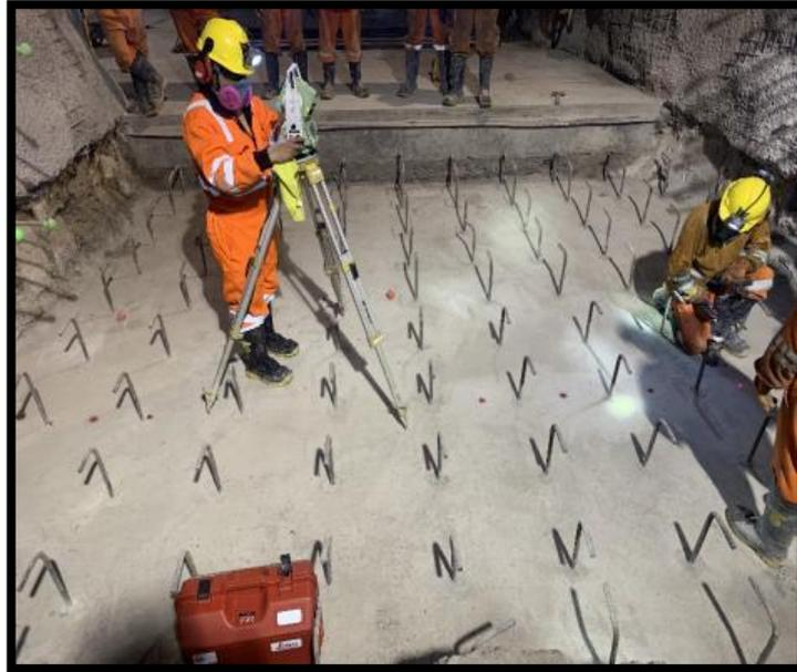
**Fotografía 10:** Vista fotográfica del armado de acero en zapatas de los muros.
