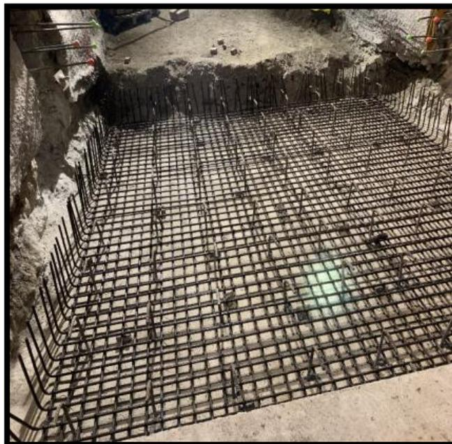
**Fotografía 11: Vista fotográfica del armado de acero en muro.**
