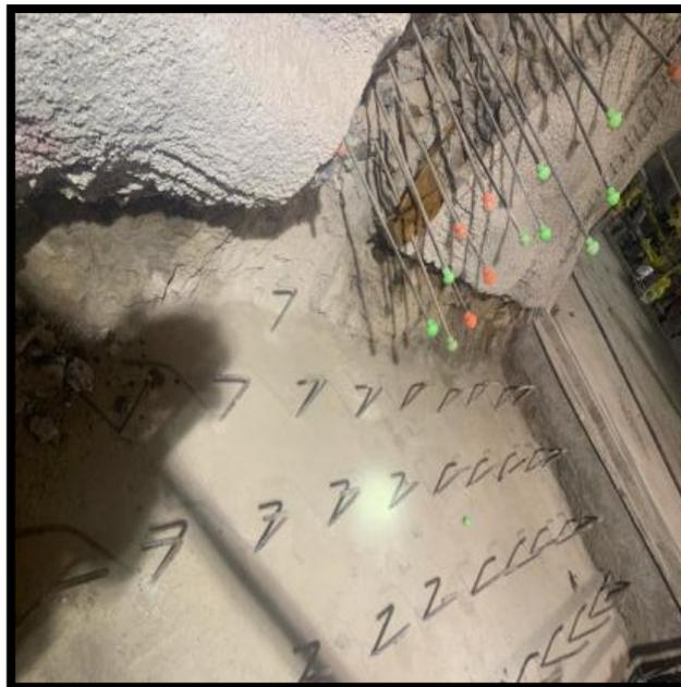
**Fotografía 9:** Vista fotográfica de la colocación de anclajes en zapatas.
