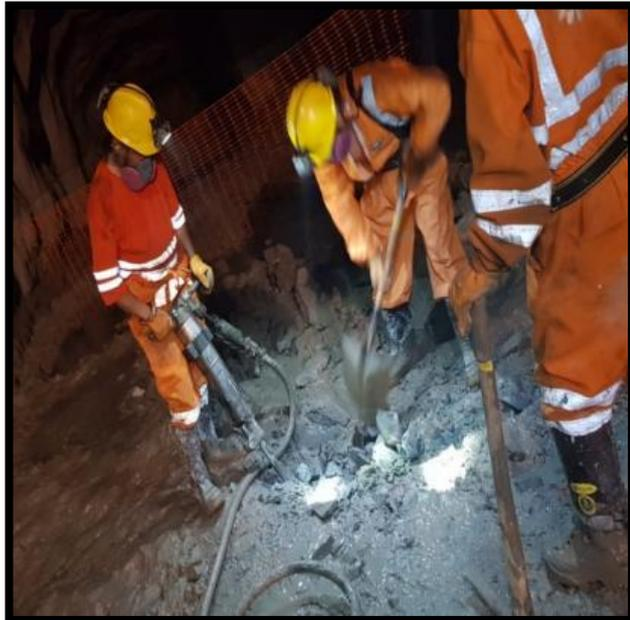
**Fotografía 3:** Vista fotográfica de la demolición de roca en hastiales para anclaje de muros.
