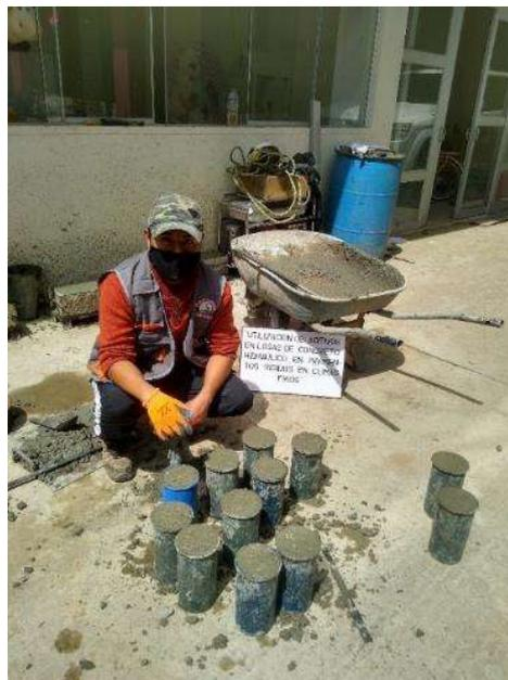
Figura 24. Elaboración de probetas cilíndricas
