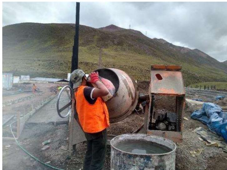
Figura 32. Preparación de la mezcla con la humedad corregida de los agregados
