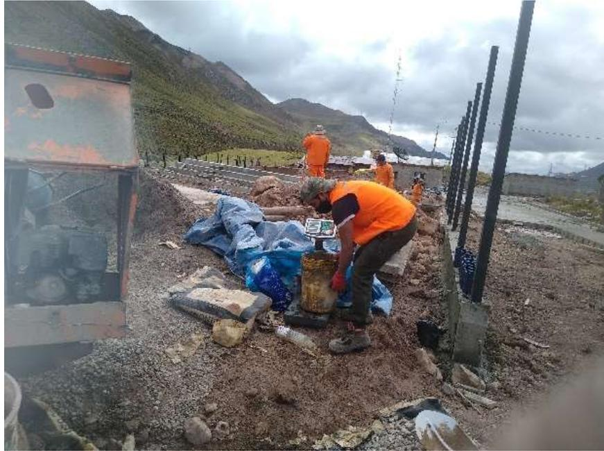
**Foto 05.** (14/05/2021). En la Localidad de Pomacocha se realizó el vaciado de la losa de pavimento de concreto según la dosis II el cual fue realizado en el laboratorio teniendo en cuenta la corrección por humedad de los agregados, el vaciado se realizó para reducir las fisuras por contracción plástica
