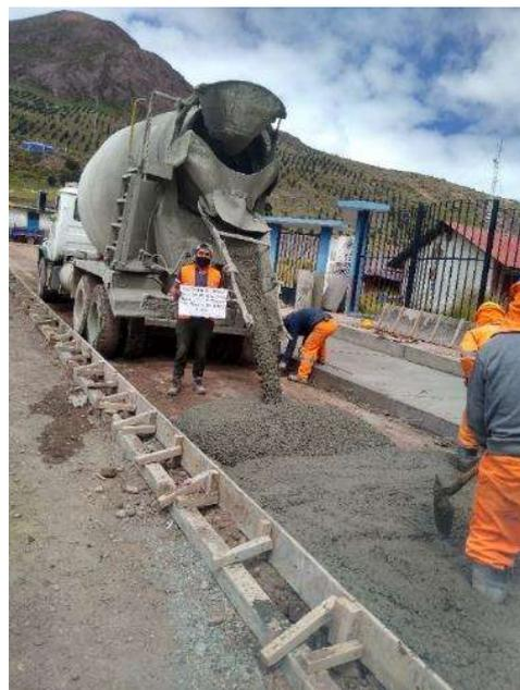
*Figura 35. Colocado de la mezcla de concreto - dosis II*
