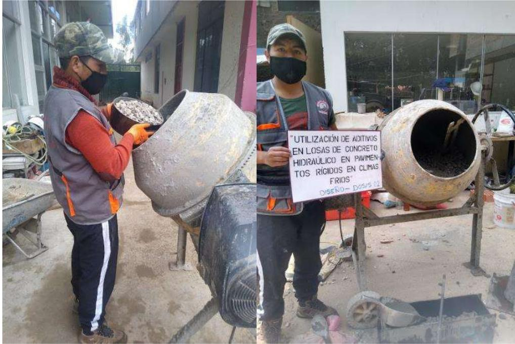
**Foto 03.** (14/04/2021 dosis patron, 15/04/2021dosis I, 16/04/2021dosis II y III). Una vez pesado los agregados en la balanza se agrega a la mezcladora de concreto para ser mezclado con el cemento, el agua, aditivo superplastificante, incorporador de aire y la fibra sintetica de las dosis patron, I, II, III.
