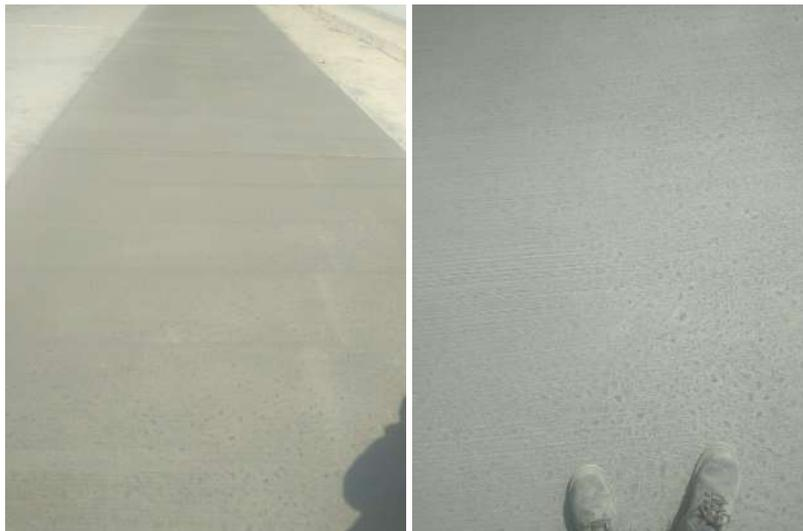
*Figura 40. No se evidencia fisuras con el uso de los aditivos*
