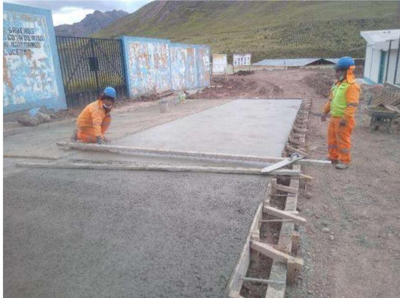
*Figura 36. Reglado de la mezcla de concreto*
