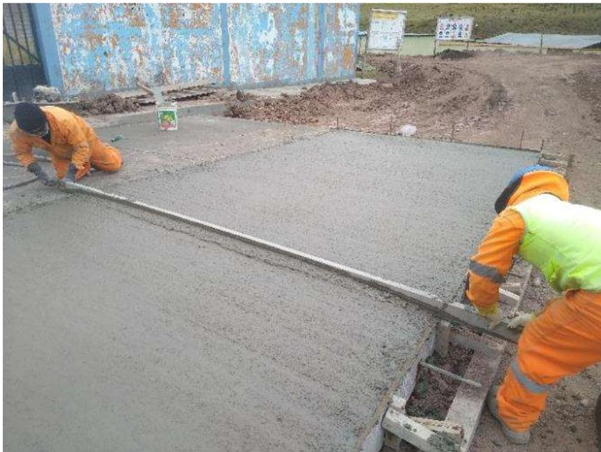
**Foto 08.** (14/05/2021). Una vez vaciado el concreto se realiza el reglado respectivo, para luego de estar en su estado plástico pase a su estado endurecido y en ese transcurso de tiempo ver si se encuentra fisuras por contracción plástica.
