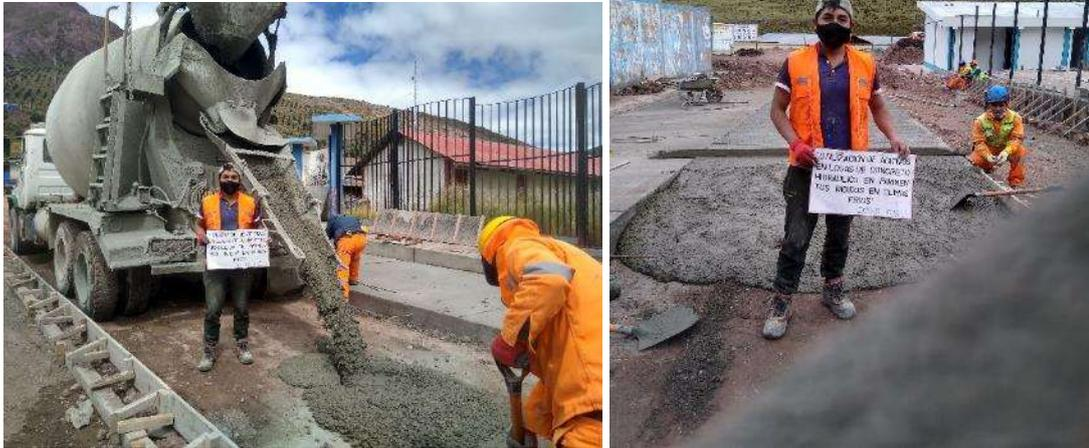
**Foto 07.** (14/05/2021) – ASTM C94. Con ayuda de un mixer se realiza el colocado del concreto con la dosificación II en 4 paños de 2.20m x 3.00m x 0.20m.
