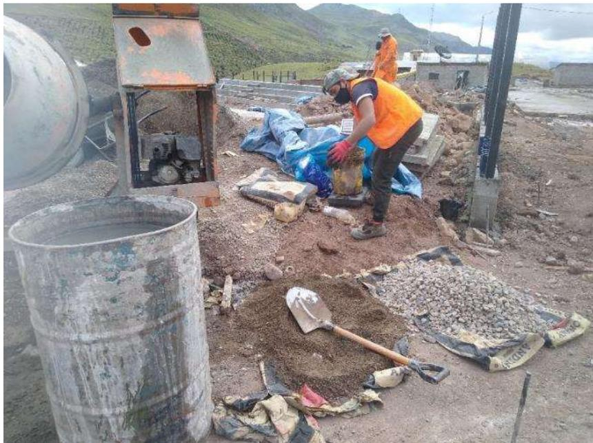
*Figura 30. Peso de los agregados con relación a una bolsa de cemento*
