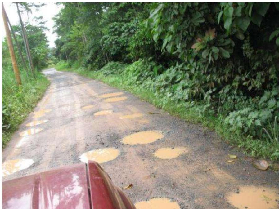
En la presente muestra algunas deformaciones y/o encalaminados que se producen en la presente vía.
