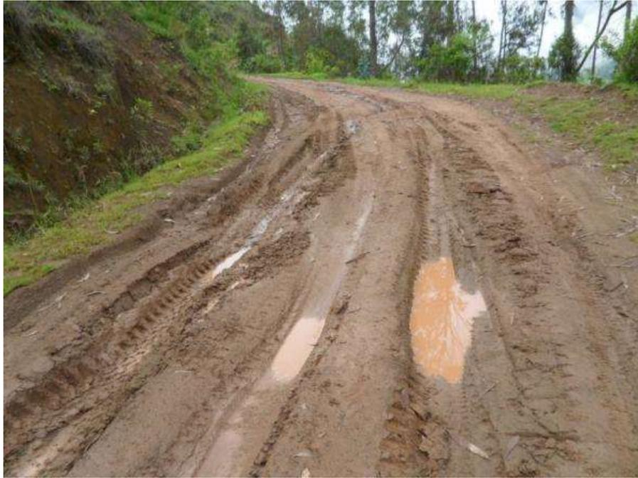
En la presente muestra los ahuellamientos que se producen esto debido al paso de vehículos pesados, acompañados de la pobre estabilización de la vía.
