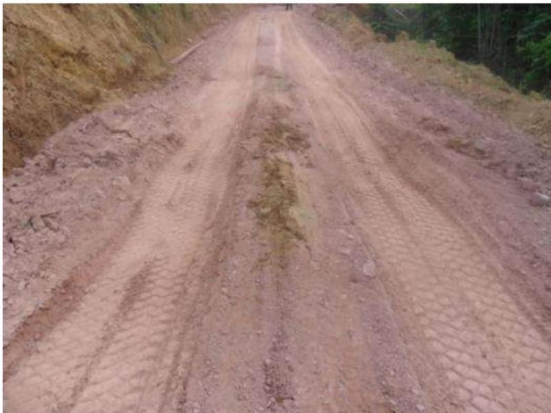
En la presente muestra el ahuellamiento que produce los vehículos pesados, los mismos que acompañados con el suelo arenoso ocasiona un tránsito restringido.
