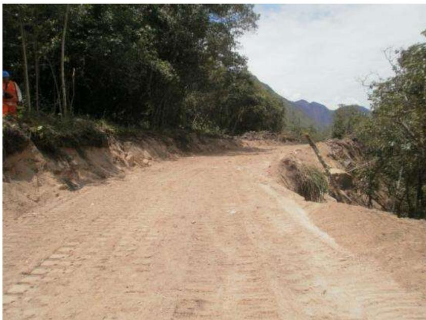
En la presente muestra el suelo arenoso que se encuentra en dicha zona, por lo que se requiere su estabilización mediante NaCl
