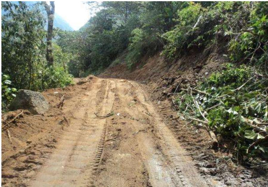
En la presente muestra el segundo tramo a mejorar, el mismo que se puede observar que requiere su intervención para estabilizar la superficie de rodadura.
