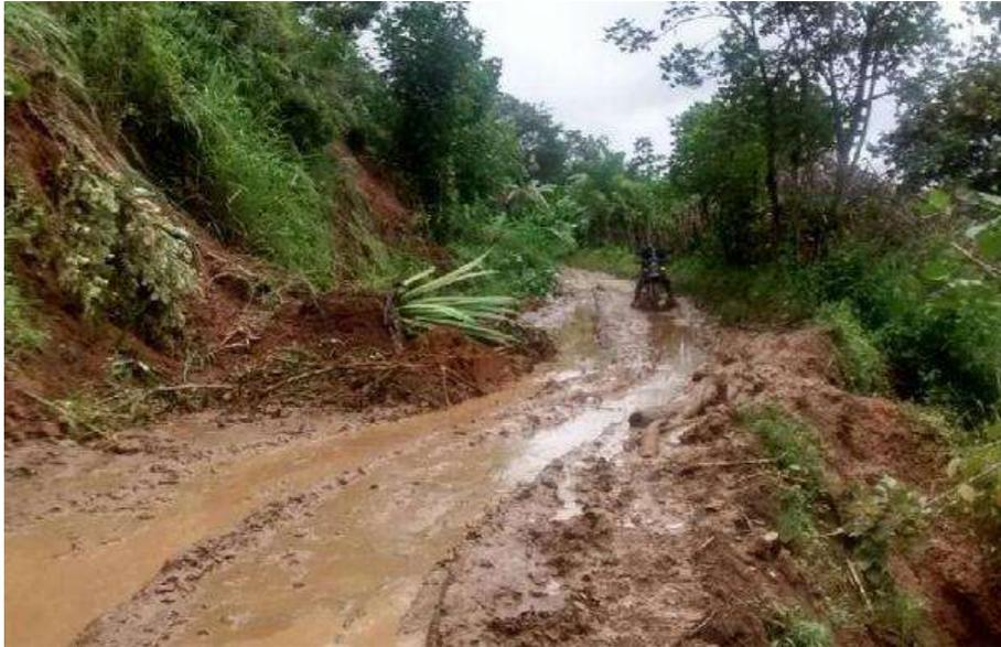
En la presente muestra parte del tramo 04, el cual se encuentra en un estado crítico ya que no tiene drenaje fluvial.
