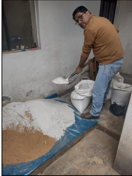
Figura 23. Adición de arena de sílice
