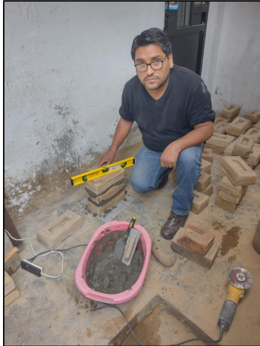
Figura 30. Control con nivel de mano
