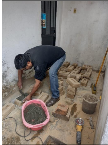
Figura 28. Asentado de pila
