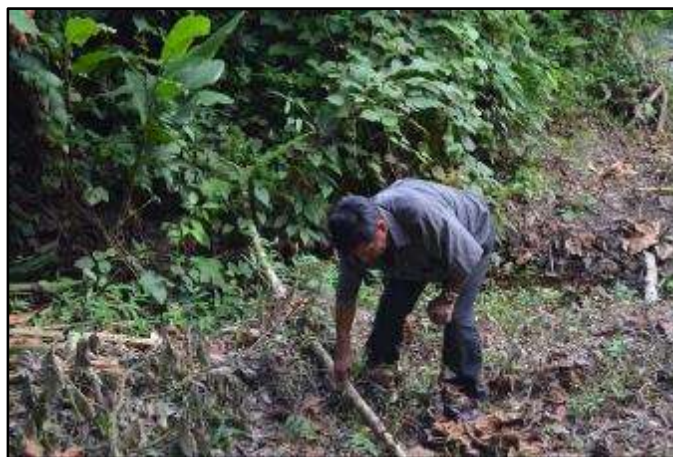
Fotografía 2.- Tramo único - Tubería PVC, diámetro = \varnothing 1 1/2", longitud = 1,000 mts. (tramo expuesto por que paso sobre una zanja)
