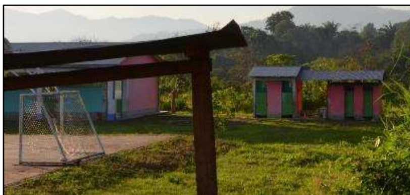
Fotografía 4.- Calidad del servicio de saneamiento existente en la distribución educativa del anexo de Santa Rosa de Cashingari
