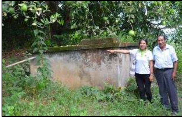
Fotografía 1.- Reservorio a 500 mt de la captación del riachuelo
