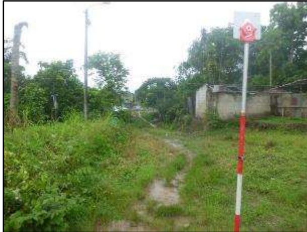
Fotografía 7.- Trabajos de levantamiento topografico
