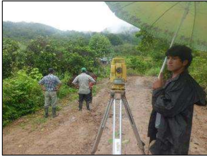
Fotografía 6.- Tramo en estudio
