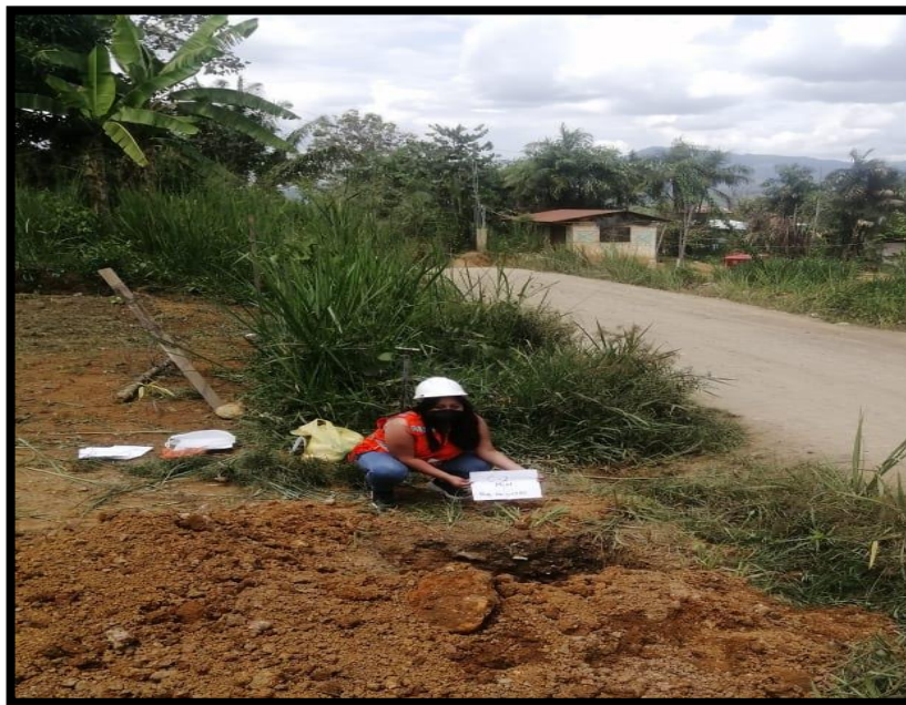
Fotografía 2. Extracción de muestra de la progresiva KM 0+500
