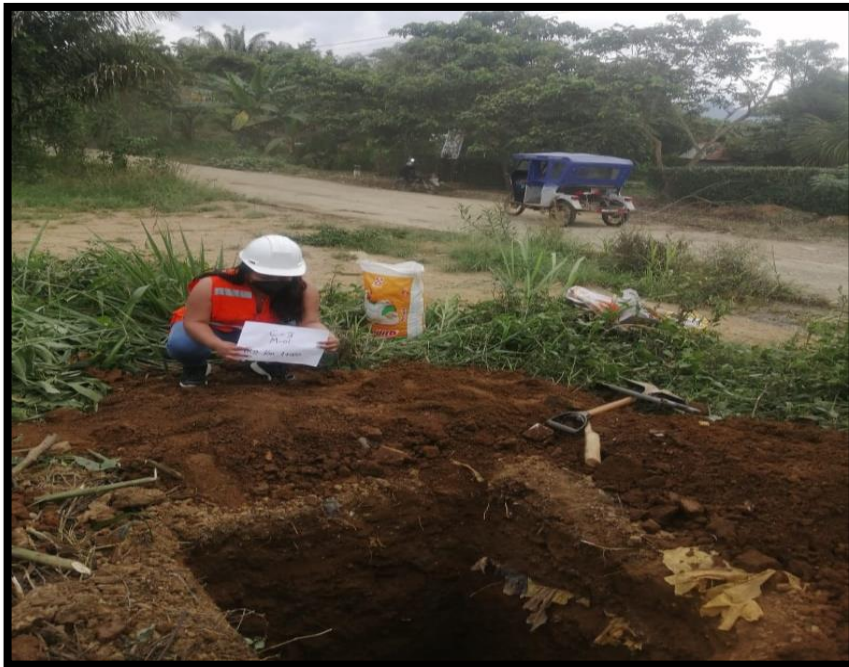
Fotografía 3. Extracción de muestra de la progresiva KM 1+000
