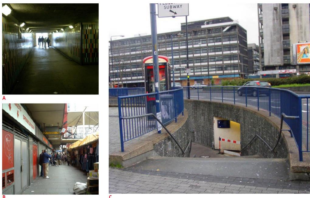
Figura 11: El Sistema de metro existente y mal utilizado desalienta a los peatones a moverse por el área, lo que reduce la demanda de los peatones y aumenta las preocupaciones sobre la seguridad de ellos mismos. Fuente: https://spacesyntax.com/project/elephant-castle-crossing/
