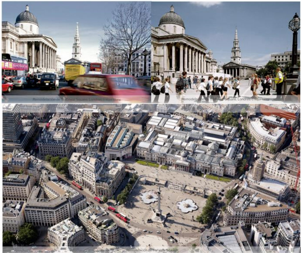
Figura 6: Remodelación de Trafalgar Square Fuente: https://arquitecturaviva.com/obras/remodelacion-de-trafalgar-square#lg=1&slide=0
