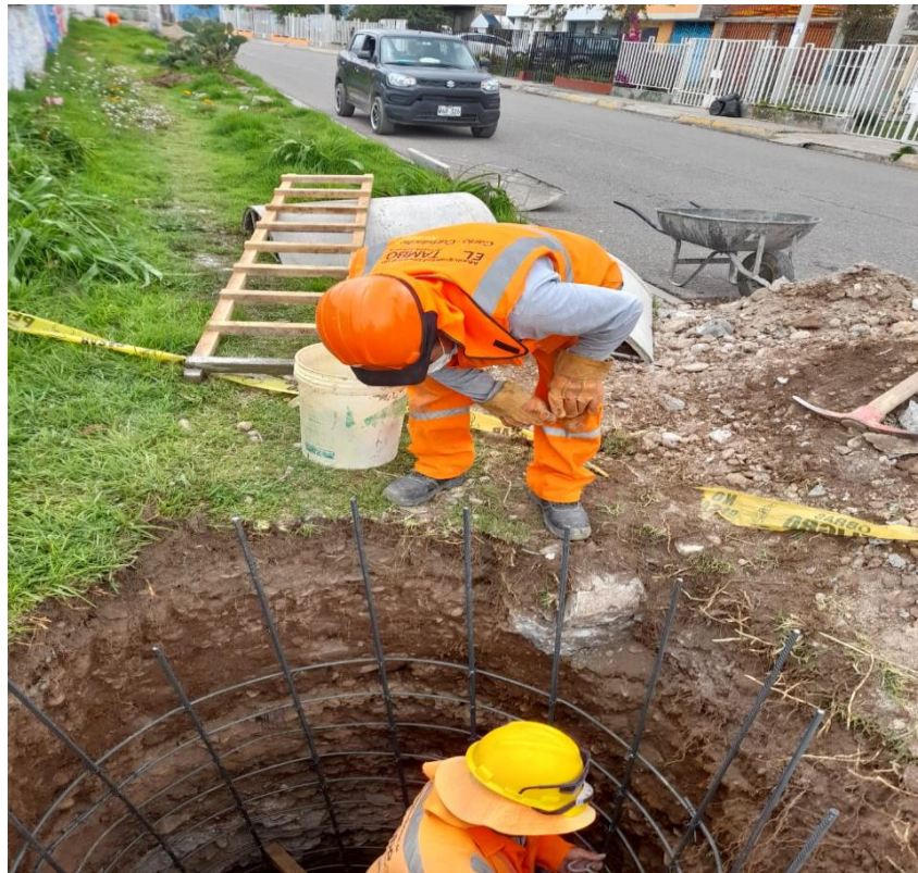
Sistema de desagüe pluvial
