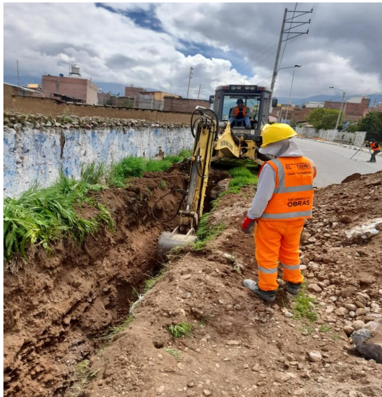
Sistema de desagüe pluvial
