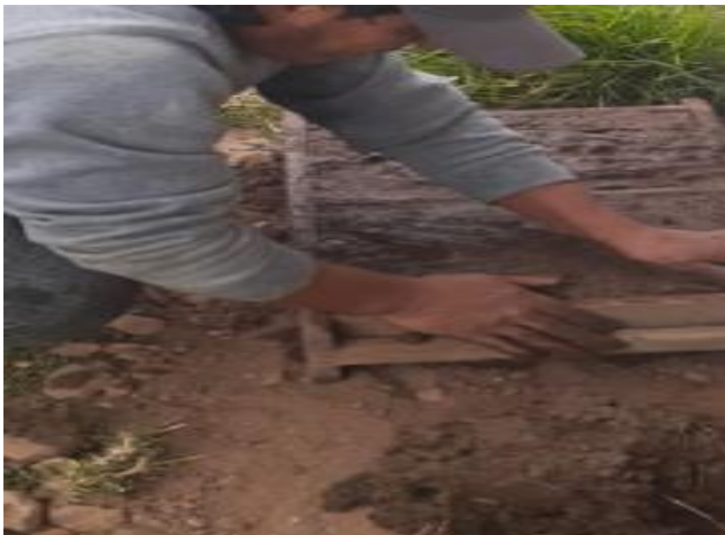
Figura 18. Llenado a las adoberas del adobe natural Fuente: Elaboración propia
