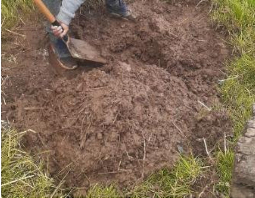
Figura 15. Combinación de la arcilla con la paja Fuente: Elaboración propia
