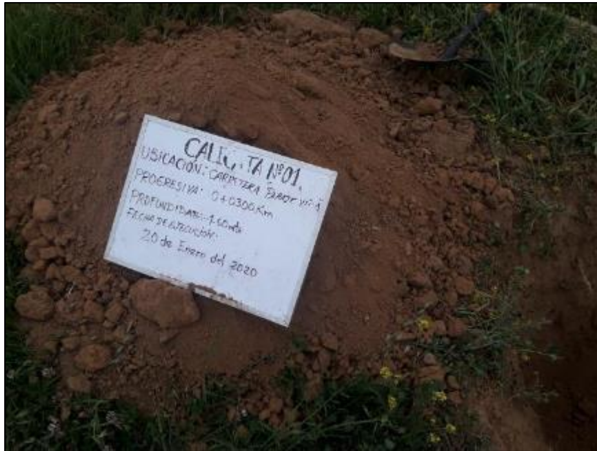
Figura 9 Excavación de la calicata 01 progresiva 0+325.00
