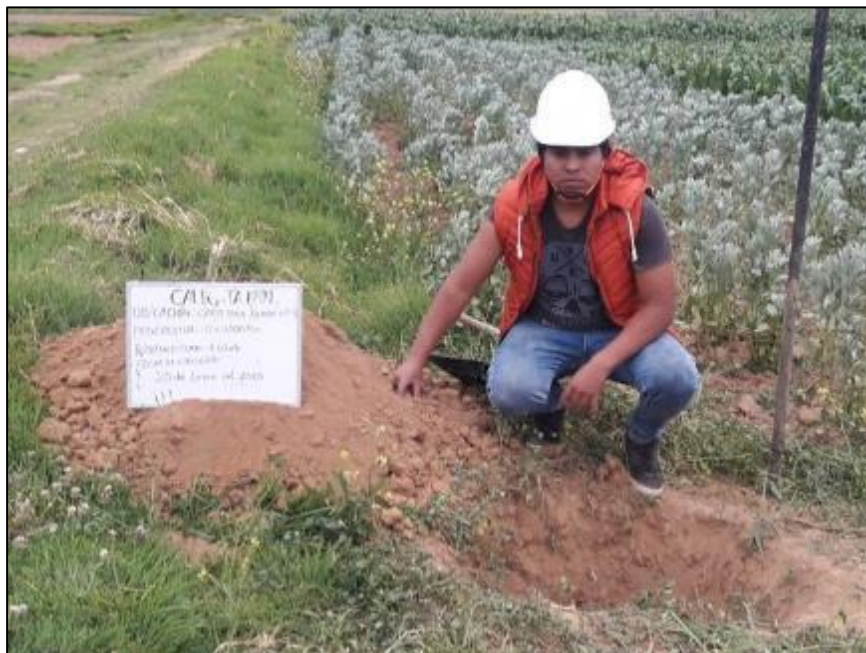
Figura 10 Excavación de la calicata 01 progresiva 0+325.00
