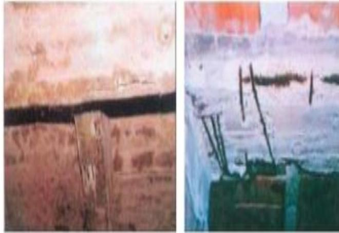
**Figura N° 11 Corrosión de la armadura en vigas**
