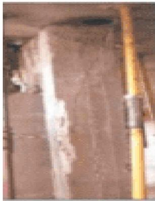
**Figura N° 01 Aplastamiento en columnas**
