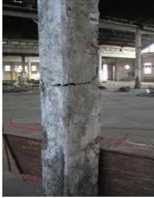
**Figura N° 02 Rotura por flexión en columnas**
