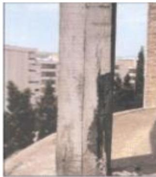
**Figura N° 05 Corrosión de la armadura en columnas**
