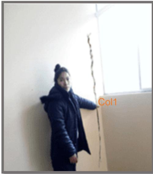
**Fisura en col1, esto ocasiona que la estructura falle**
