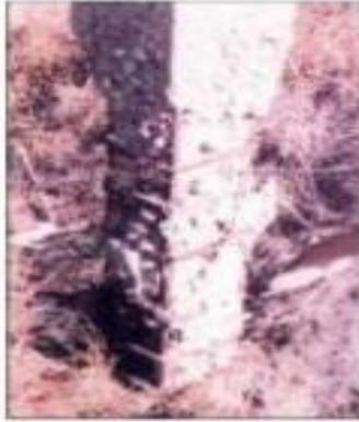
**Figura N° 06 Segregación del concreto en columnas**
