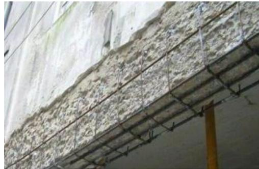
**Figura N° 15 Encamisado de viga**
