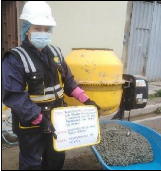
Fotografía 8: Medición de la temperatura del concreto patrón de acuerdo a la NTP 339.184.
