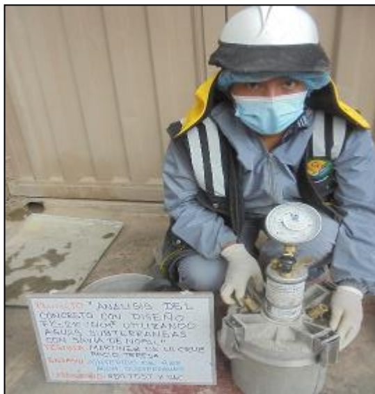
Fotografía 18: Medición del contenido de aire en el concreto con agua subterránea mediante el método de presión y la NTP 339.083.
