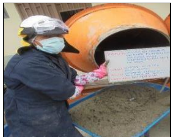
Fotografía 34: Medición de la temperatura del concreto con agua subterránea y savia de nopal al 0.30% (aditivo) según la NTP 339.184.
