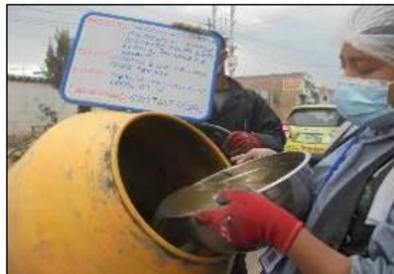
Fotografía 23, Fotografía 24 y Fotografía 25: Vista de materiales tales como agregado, savia de nopal al 0.10% (aditivo), agua subterránea y cemento para la elaboración del concreto, de acuerdo a la NTP 339.183.
