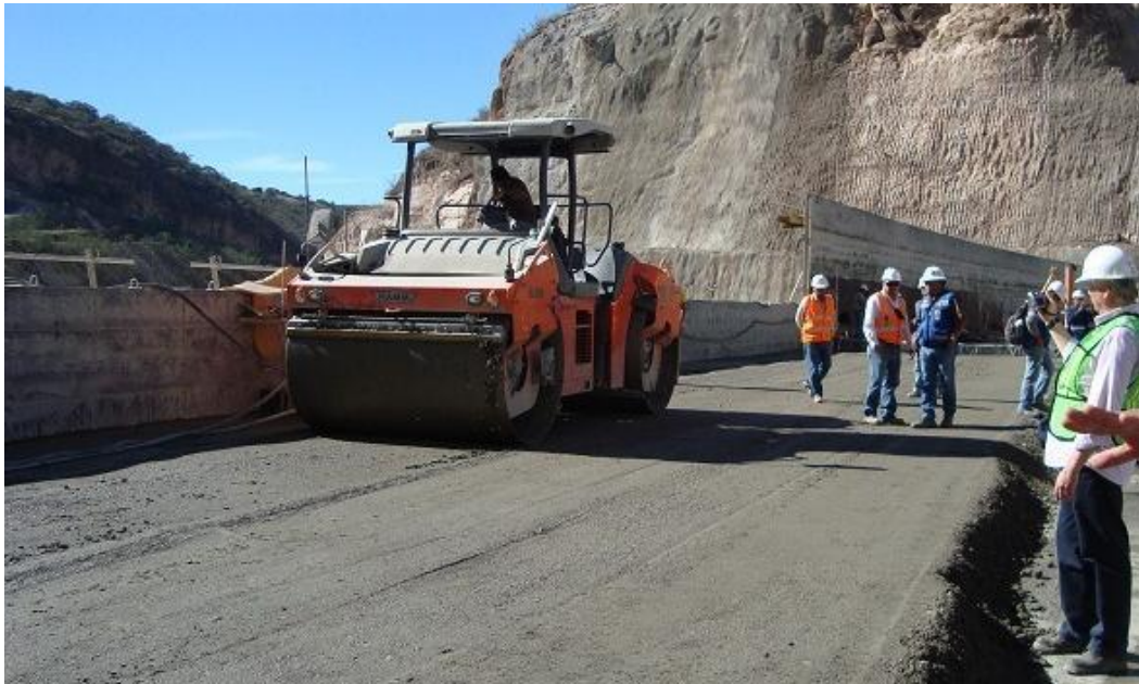
Figura 2: Construcción de represas con Concreto Compactado con Rodillo
