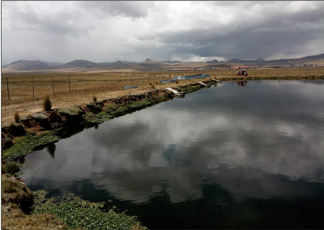
Fotografía N° 3: Se muestra la laguna de estabilización en mal estado
