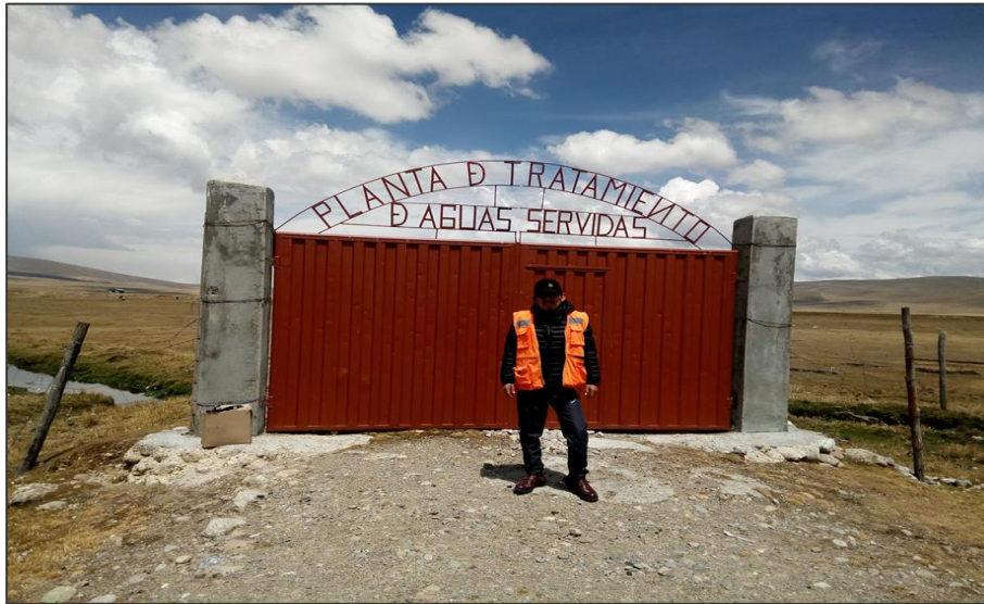
Fotografía N° 1: PTAR de la Provincia de Junin
