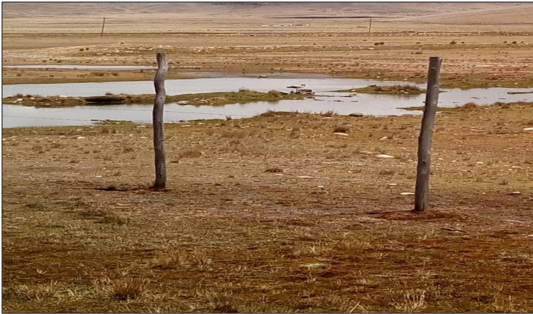
Fotografía N° 5: Aguas residuales del escape del PTAR, un daño ecológico.
