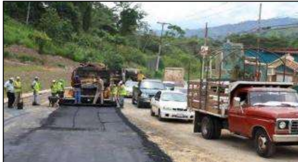
Figura 5. Mejoramiento con asfalto.
