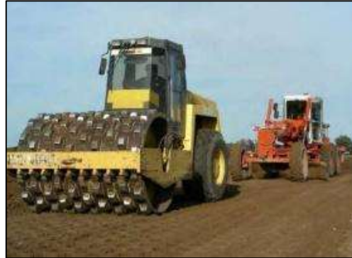
Figura 1. mejoramiento por compactación aplicando rodillo “pata de cabra”.
