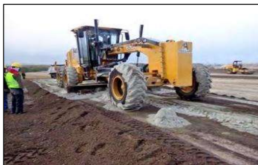
Figura 3. Mejoramiento con cemento.
