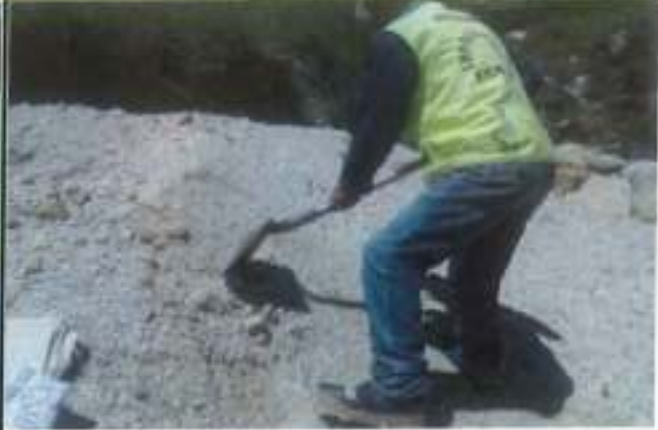
Extracción parte céntrica del desmonte malla 1/4"
