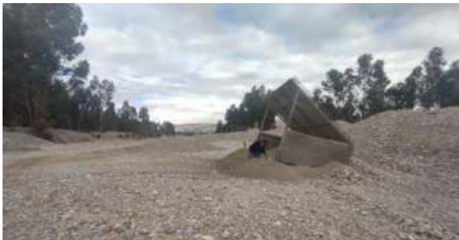
Figura N° 25: Extracción de la arena gruesa – Río Seco - Apata
