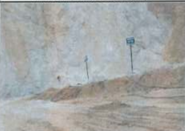
Zona de extracción del material con explosivos
