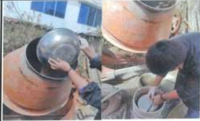
Se pone en funcionamiento la mezcladora, se adiciona el agregado fino (pasante de la N°4) , cemento y el agua .
