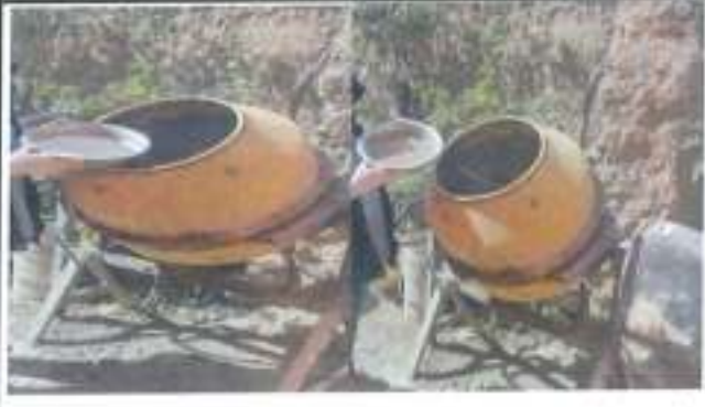
Se pone en funcionamiento la mezcladora, se adiciona el agregado fino pasante de la N°4 (arena silícea y arena gruesa), cemento y el agua.
