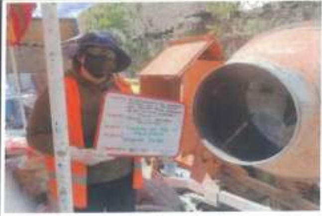
Humedecer la mezcladora
