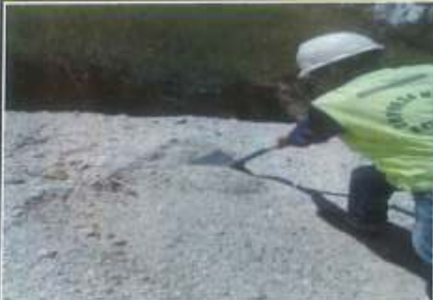
Extracción parte superior del desmonte malla 1/4"
