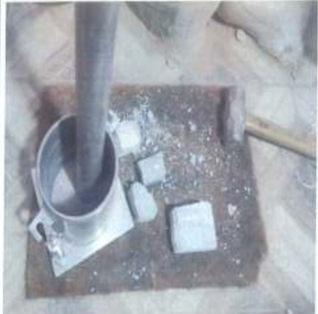
Se pulveriza el adoquín para utilizar el material fino.
