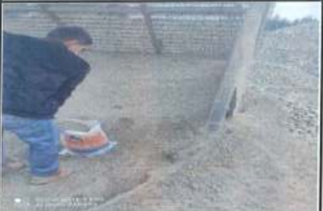
Extracción del material parte intermedia
