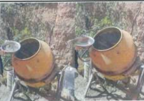
Se observa la adición de cemento y agua en la mezcladora
