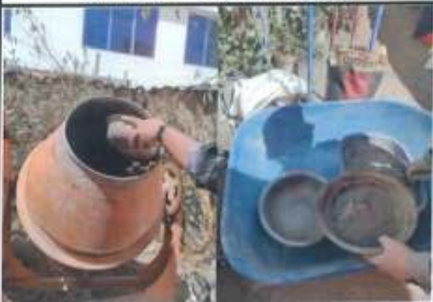
Se observa la adición del cemento en la mezcladora
