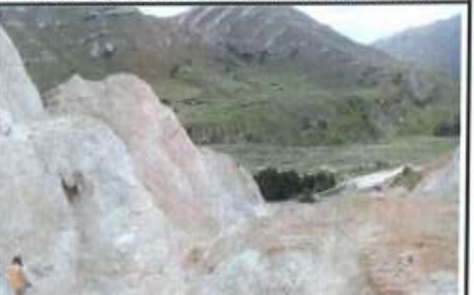
Arrastre del material en forma de huayco
