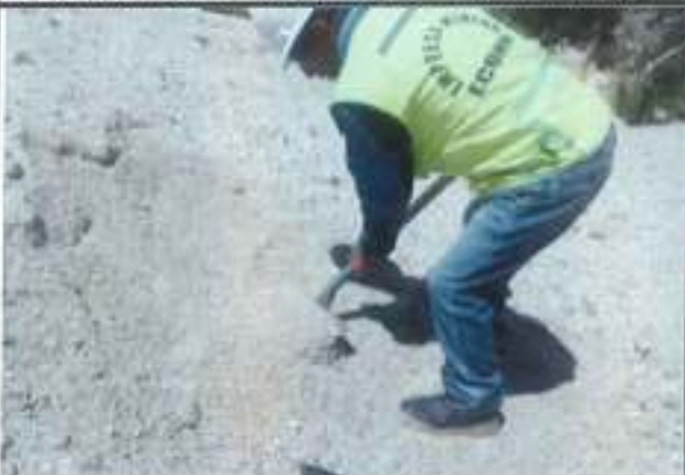
Extracción parte inferior del desmonte malla 1/4"
