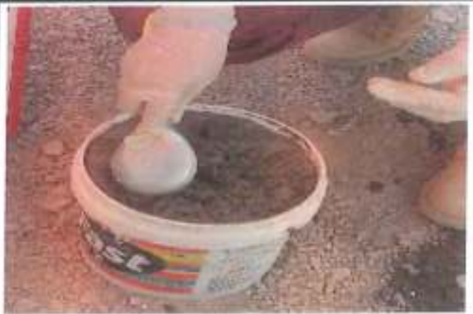
Se enrasa la mezcla de concreto.
