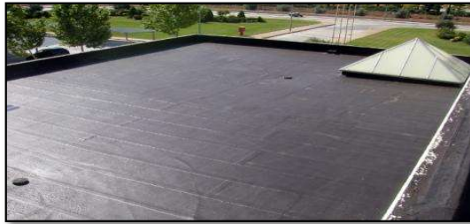
Figura 8: Impermeabilización con resina polimérica de cubierta en caliente.
