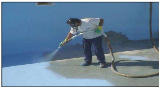
Figura 9: Impermeabilización con resina polimérica en frío.
