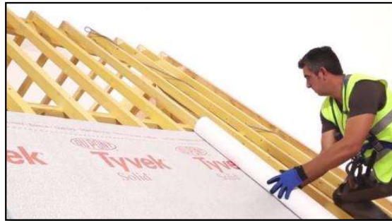
Figura 12: Instalación de láminas impermeables transpirables.
