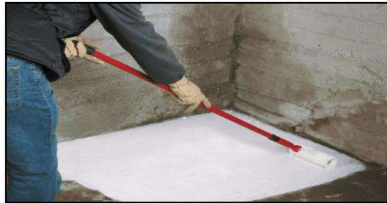
Figura 10: Impermeabilización de resina acrílica.
