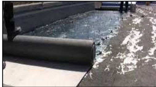
Figura 5: Impermeabilización de cubierta de aluminio sintética.
