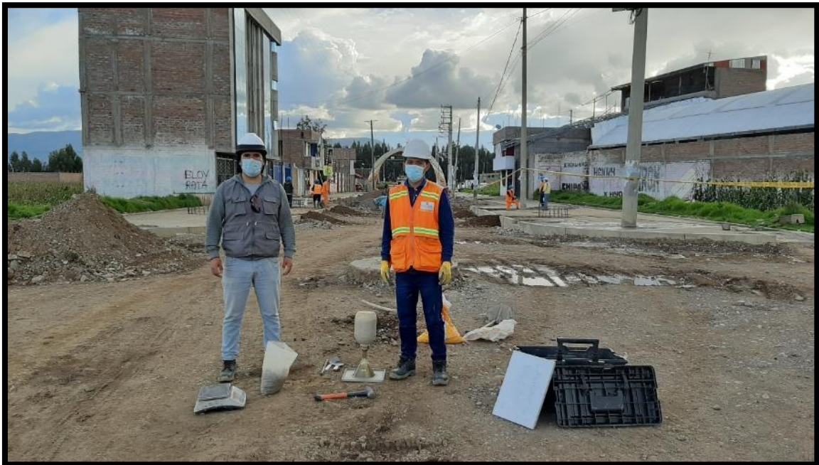
En la presente foto se observa los trabajos que se realiza para la Densidad de Campo a nivel de sub base.
