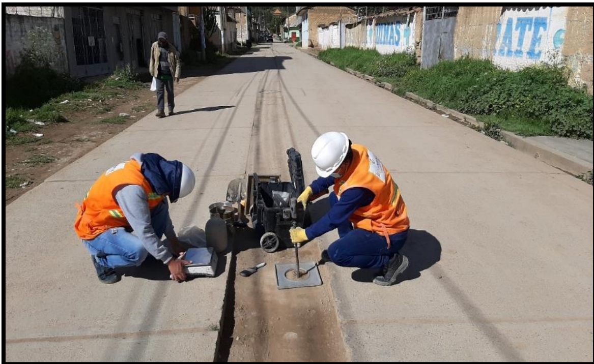
En la presente foto se observa la extracción de material compactado a nivel de base para la Densidad de Campo
