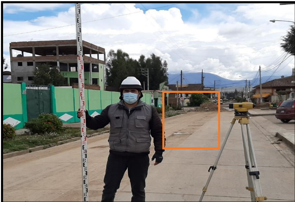
En la presente foto se observa el asentamiento del pavimento rígido de la Av. Alfonso Ugarte
