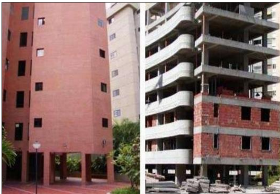
Figura 9. Edificaciones sin continuidad en elevación
