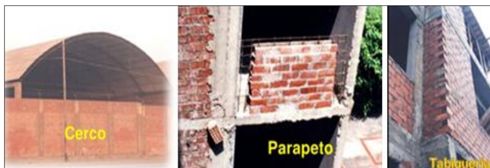
Figura 4. Muros no portantes
