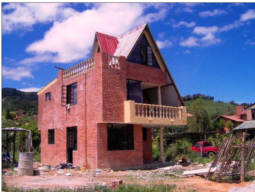
Figura 1. Casa campo albañilería simple
