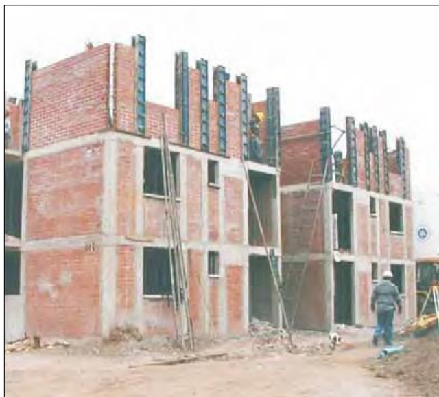
Figura 2. Edificio de albañilería confinada
