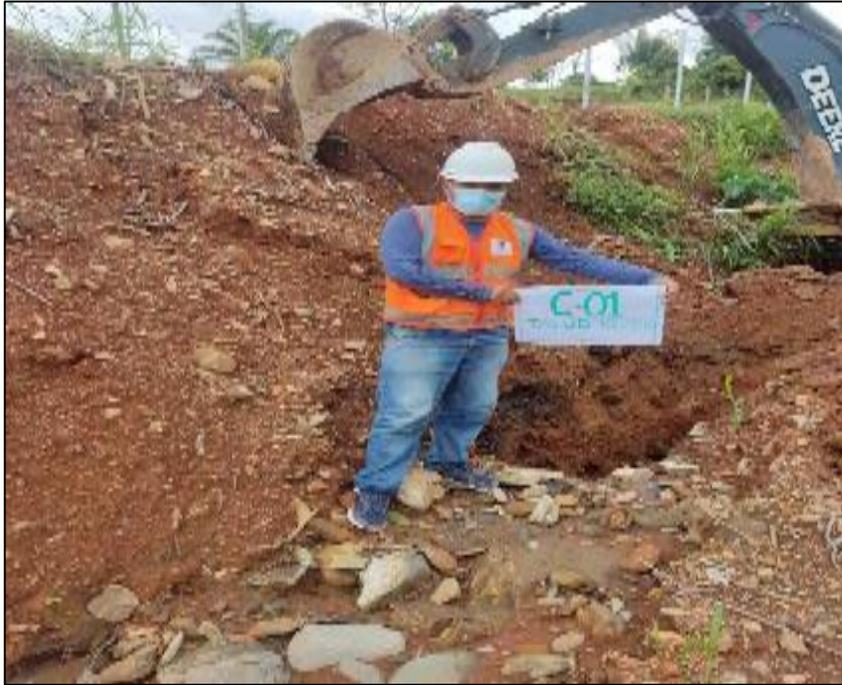
**Fotografía17:** Calicata Nª 01 talud de relleno
