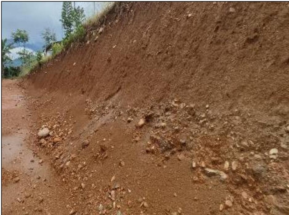
**Fotografía1:** Desprendimiento de partículas de suelo en el talud
