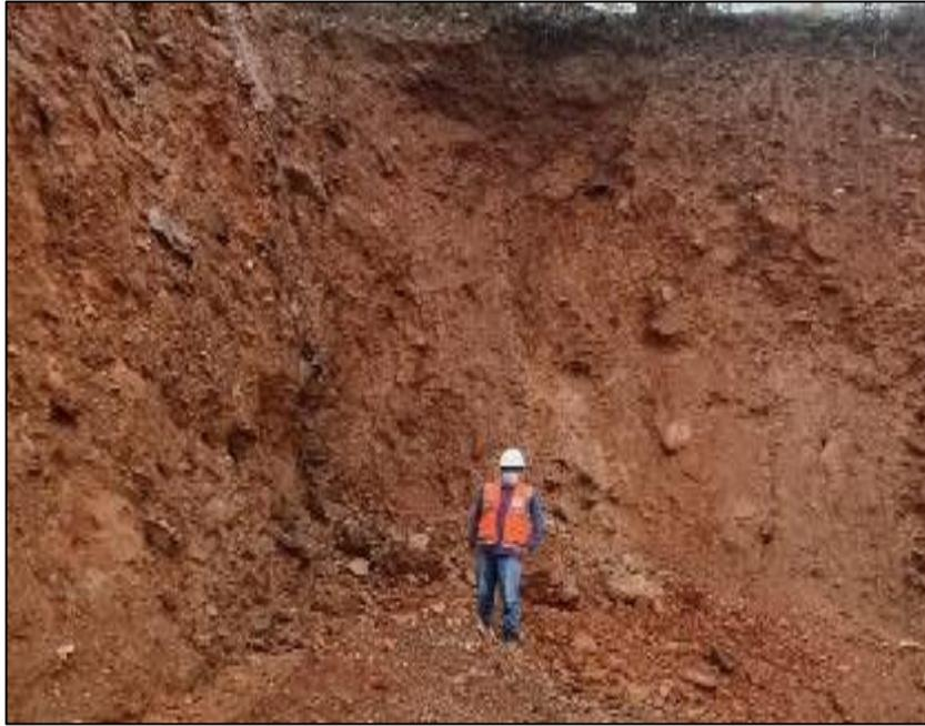
**Fotografia13:** Talud N° 03 presencia de falla por desprendimiento de suelo
