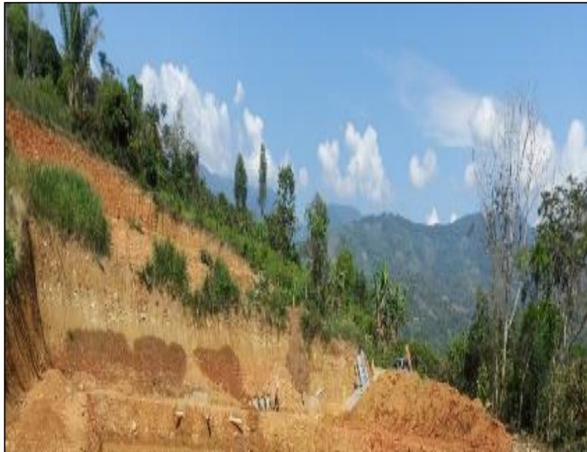
**Fotografía12:** Talud N° 02 superficie de talud con carencia de vegetación
