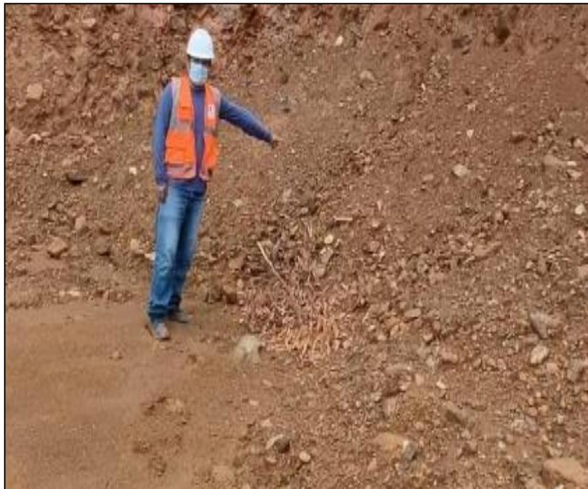
**Fotografía10:** Talud N° 02 presencia de falla por erosión hídrica
