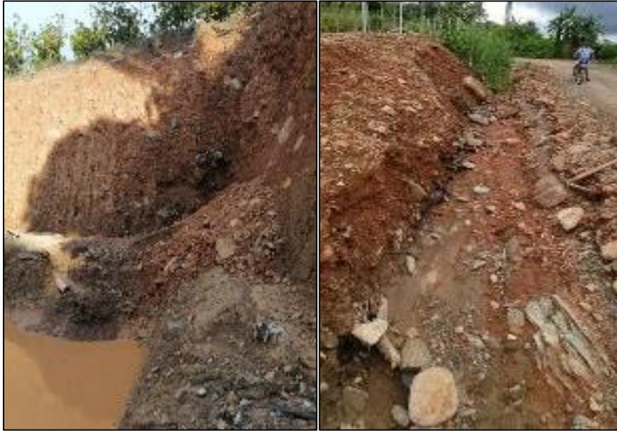
**Fotografía2:** Presencia de falla en taludes
