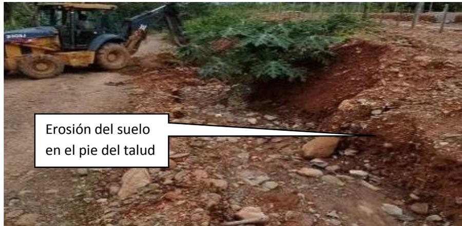
**Fotografía5:** Talud de relleno N° 01 falla por erosión
