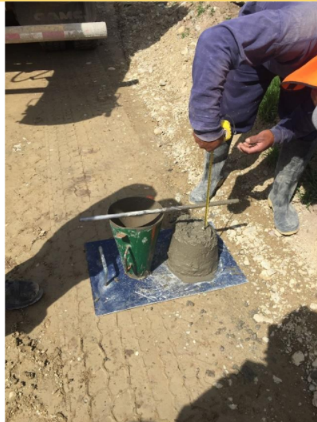
FOTOGRAFÍA N 28: ENSAYO DE ASENTAMIENTO
