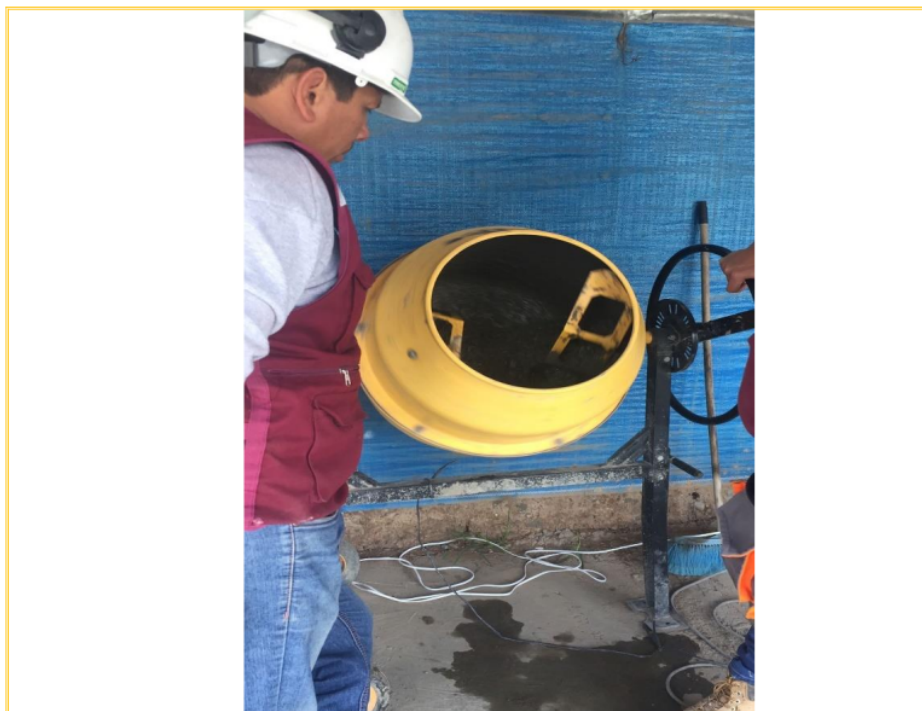
FOTOGRAFÍA N 19: MEZCLADO DE MATERIAL
