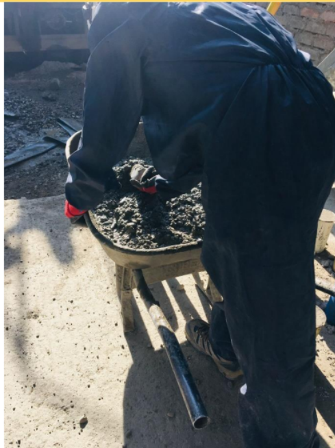
FOTOGRAFÍA N 27: ENSAYO DE ASENTAMIENTO
