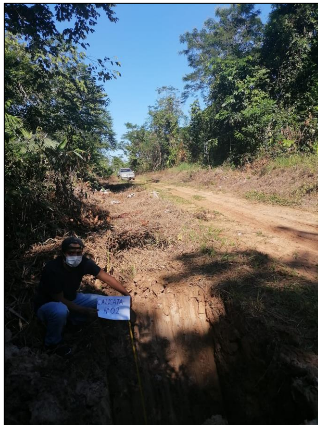
Fotografía 2: Excavación de la calicata 2, camino vecinal Mishiyacu – La Piedra
