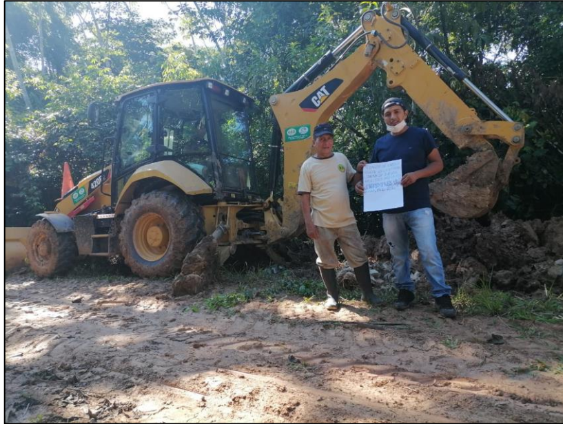
Fotografía 1: Excavación de la calicata 1, camino vecinal Mishiyacu – La Piedra
