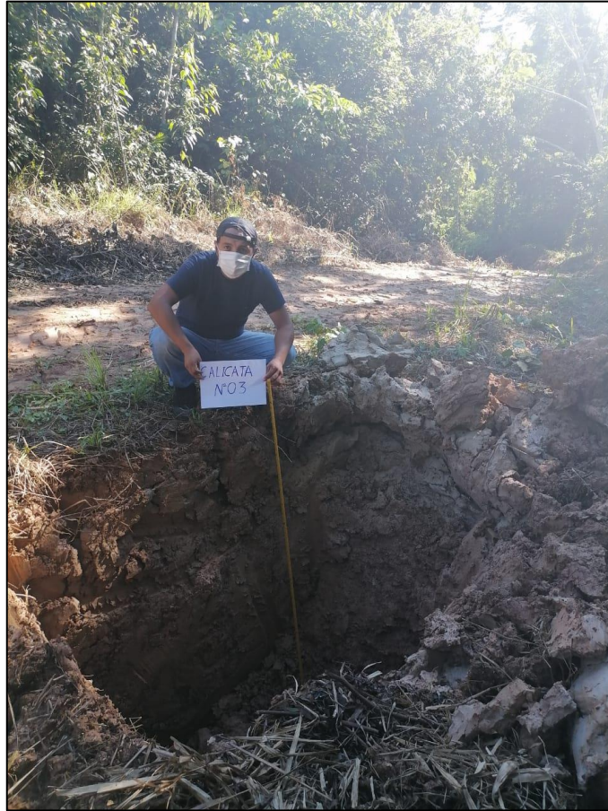
Fotografía 3: Excavación de la calicata 3, camino vecinal Mishiyacu – La Piedra
