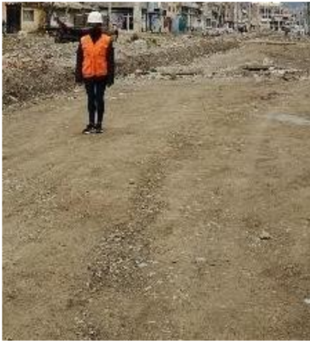
Foto N°03 Conformación de a capa de la sub rasante
