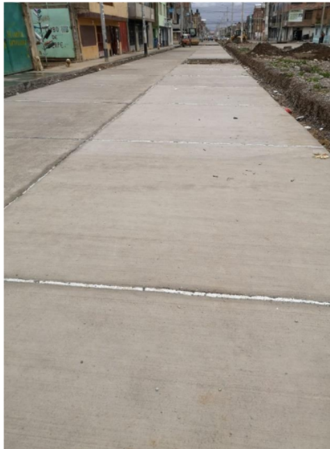
Foto N°04 Capa del pavimento de concreto hidráulico f_c=210\text{kg/cm}^2
