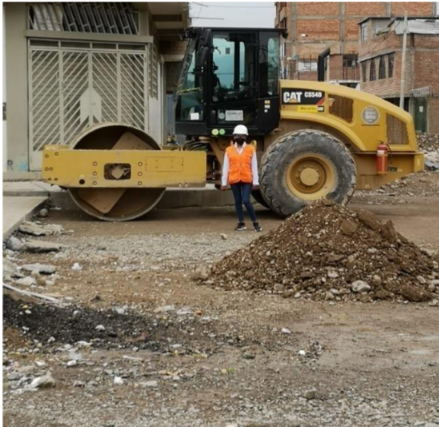
Foto N°02 Maquinaria para la compactación de la base granular
