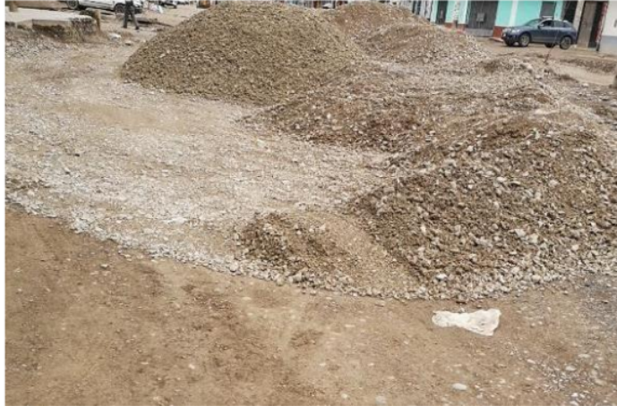
Foto N°01 Conformación del material granular de la base
