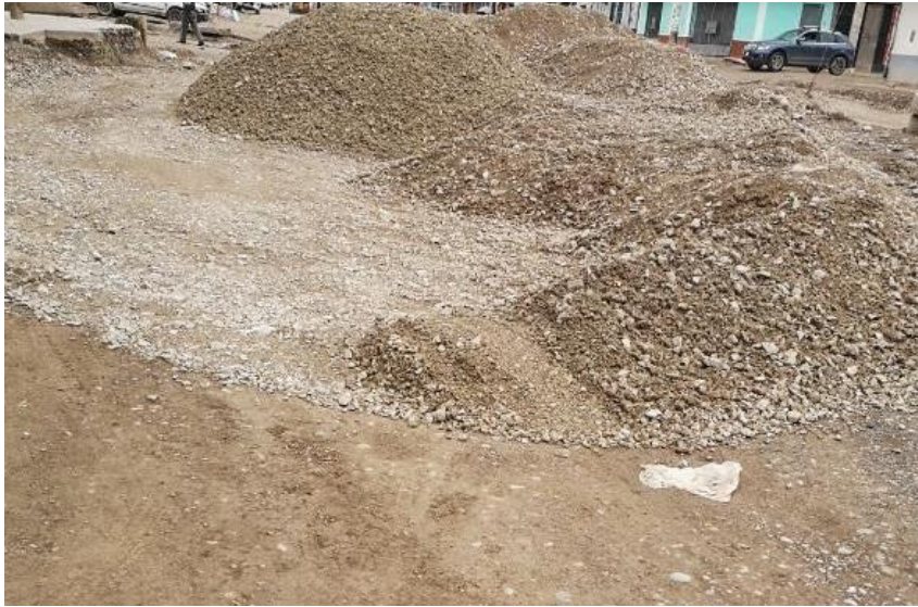
Foto N°01 Conformación del material granular de la base
