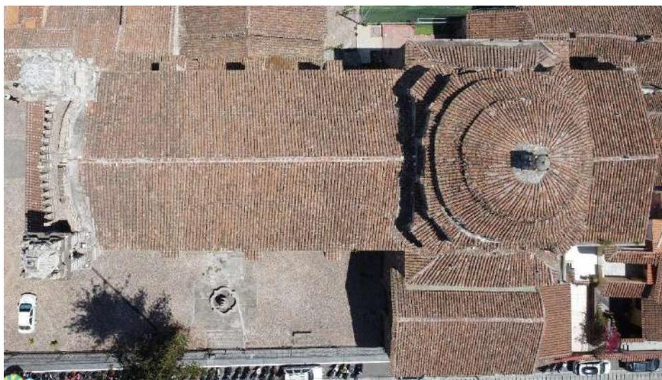
**CUBIERTA A DOS AGUAS CON CÚPULA**
