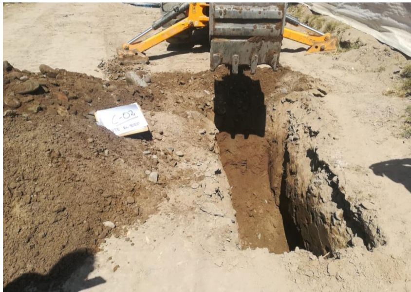
Figura 14- Excavación de calicata 02.
