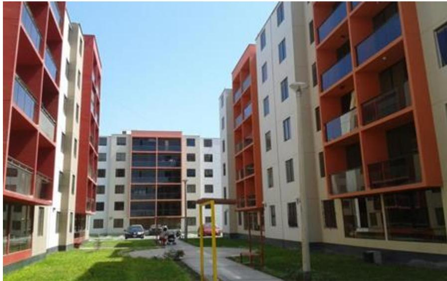
Figura 3 Edificaciones con muros de ductilidad limitada Fuente: Muros de ductilidad limitada, Genner Villareal (2015).
