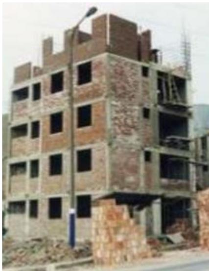
Figura 1. Edificación de albañilería confinada.
