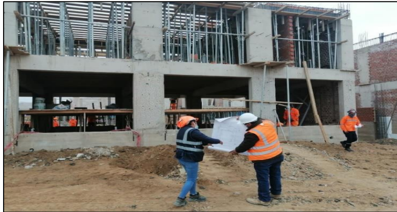
Figura 37 : Control de obra y verificación
