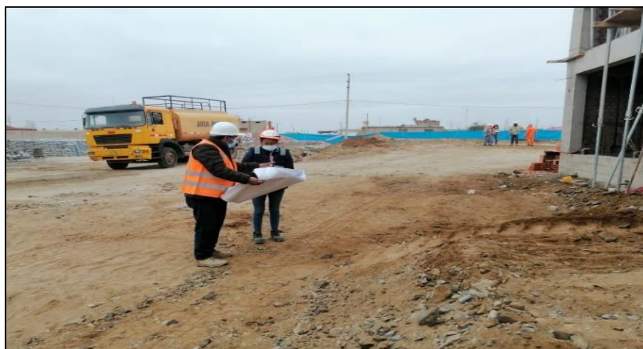
Figura 38 : Control de obra
