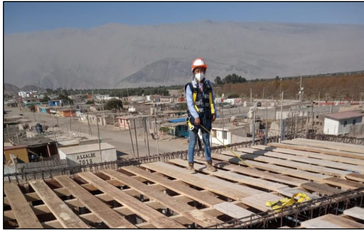
Figura 41 :Control en obra
