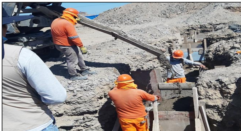
Figura 45 : Cuadrilla de concreto en cimientos
