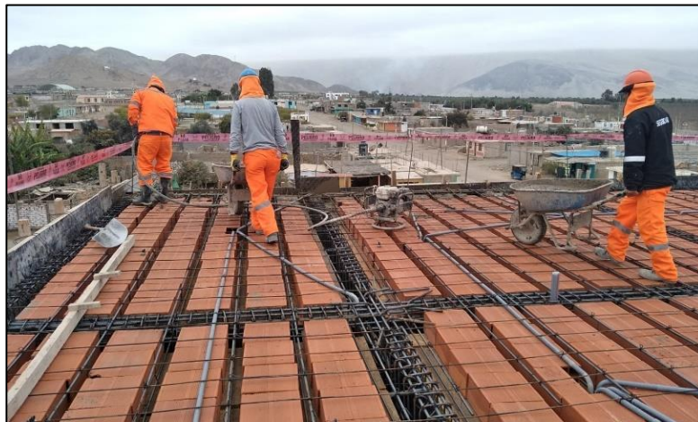
Figura 42 : Cuadrilla de concreto en losas
