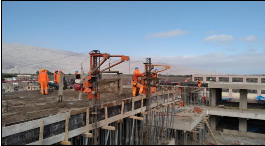
Figura 40 : Cuadrilla de concreto en losas
