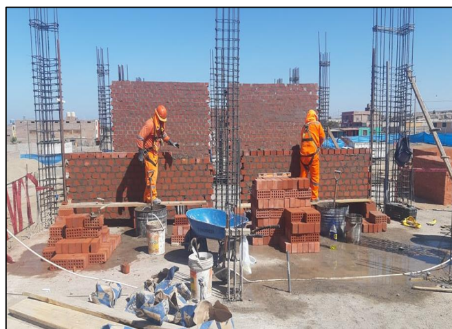
Figura 44 : Cuadrilla de abañiles
