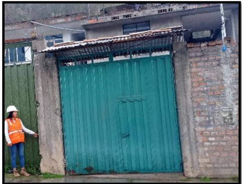
**Fotografía N°6 DISCONTINUIDAD DE ELEMENTOS ESTRUCTURALES (VIGA-COLUMNA)**
