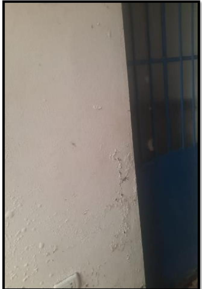
**Fotografía N°4** Humedad en muros e inconsistencia en altura de piso a techo
