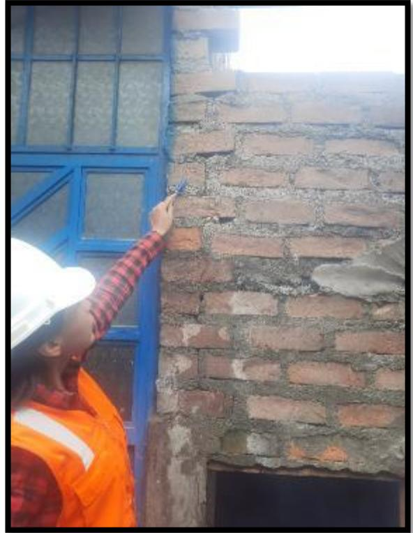
**Fotografía N°7 Grieta en muro por asentamiento diferencial y Presencia de humedad en losa y punto de luz**
