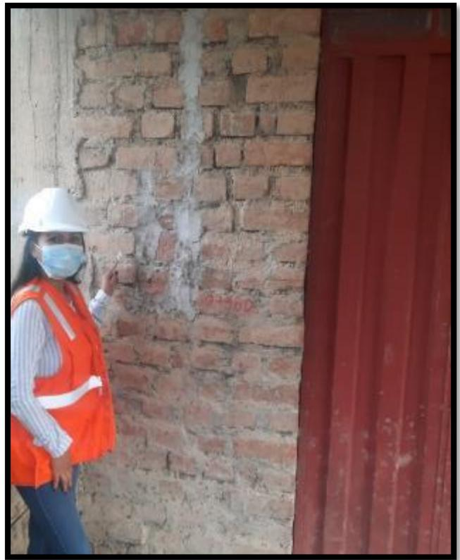
**Fotografía N°8** Incorrecto encofrado de columna en fachada principal y Tubería de desagüe expuesta en muros interiores
