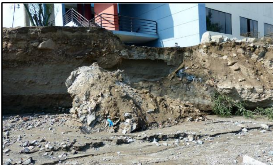
Figura 13. Desbordamiento de huayco que afecta locales de la Universidad Nacional de Educación Enrique Guzmán y Valle.
