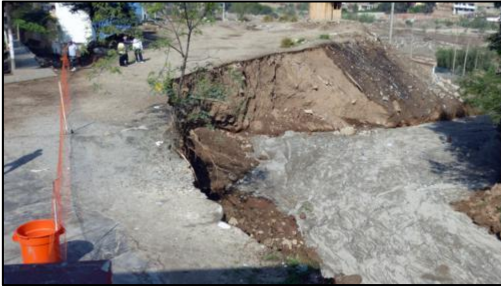
Figura 15. La falta de encauzamiento afecta áreas colindantes a la de la quebrada Santo Domingo.
