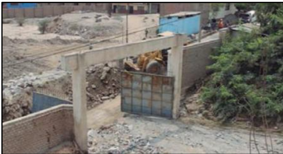
Figura 12. Acumulación de material de colmatación producto de la inundación en la avenida Circunvalación.
