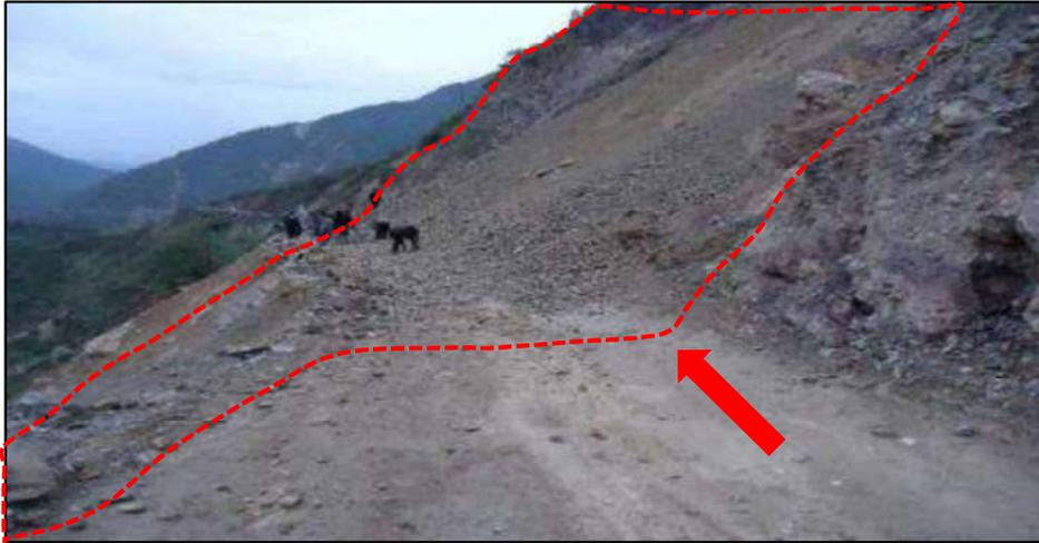
Fotografía 1. Se visualiza en el Km 267 + 900 al Km 268+000, el deslizamiento de talud provocado por precipitación pluviales y movimiento sísmico.
