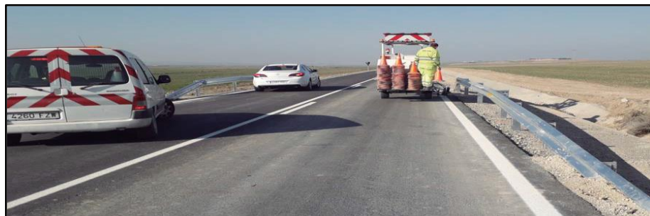
Figura 17. Vista Demarcación vial sobre carpeta asfáltica.
