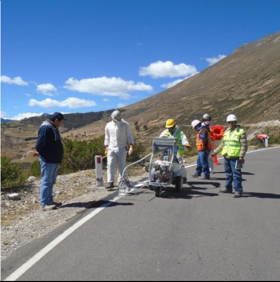
Foto N° 5. Verificación labores de imprimación
