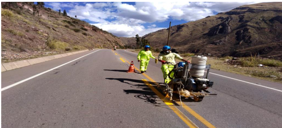
Figura 16. Vista sobre demarcación vial.
