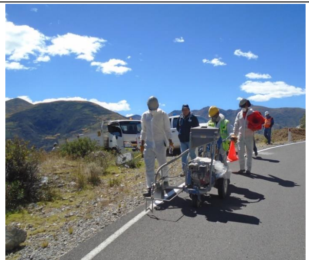
Foto N° 4. Labores de demarcación vial lateral
