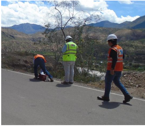
Foto N° 11. Toma de muestra con equipo portátil
