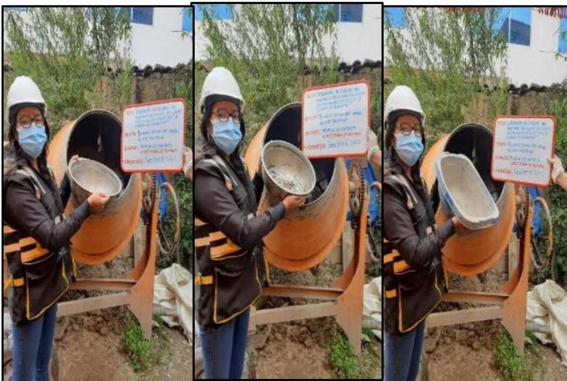
**Fotografía 62, Fotografía 63:** Incorporación de materiales tales como cemento, agua y fibra de aluminio reciclado para la elaboración del concreto del GE<sub>3</sub>. Según NTP 339.183.
