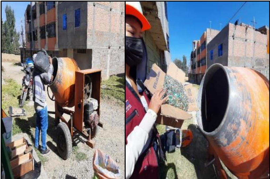
**Fotografía 87:** Elaboración del concreto para el tramo de prueba de losa de pavimento rígido con una mezcla de concreto correspondiente al GE<sub>1</sub>.
