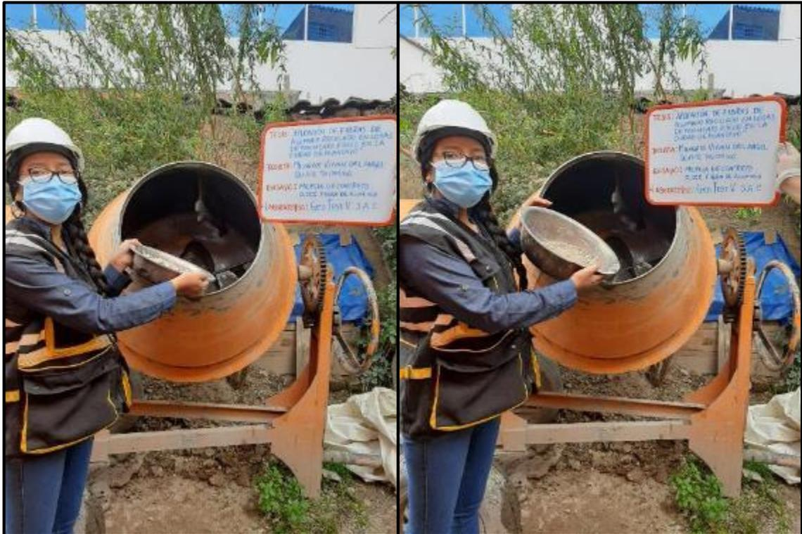
**Fotografía 48, Fotografía 49:** Vista de los agregados incorporados a la mezcla para la elaboración del concreto del GE<sub>2</sub>. Según NTP 339.183.
