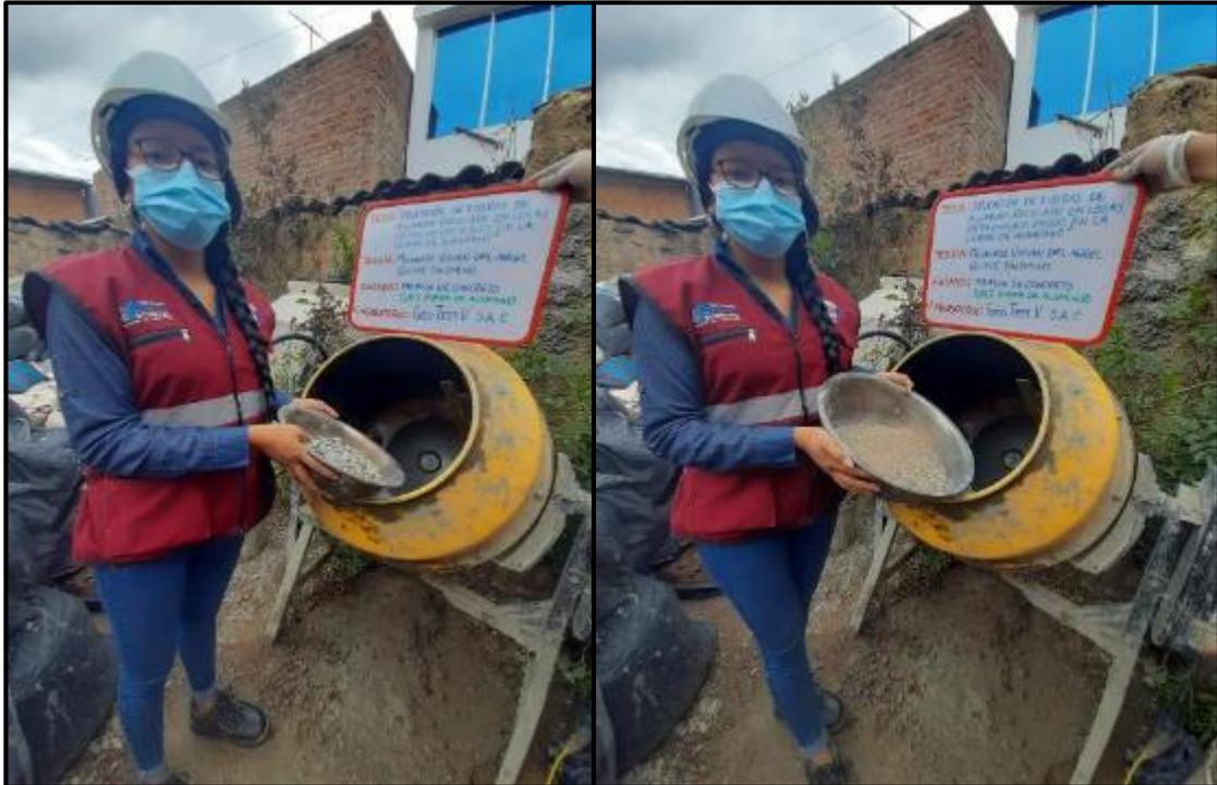
**Fotografía 36, Fotografía 37:** Vista de los agregados incorporados a la mezcla para la elaboración del concreto del GE<sub>1</sub>. Según NTP 339.183.
