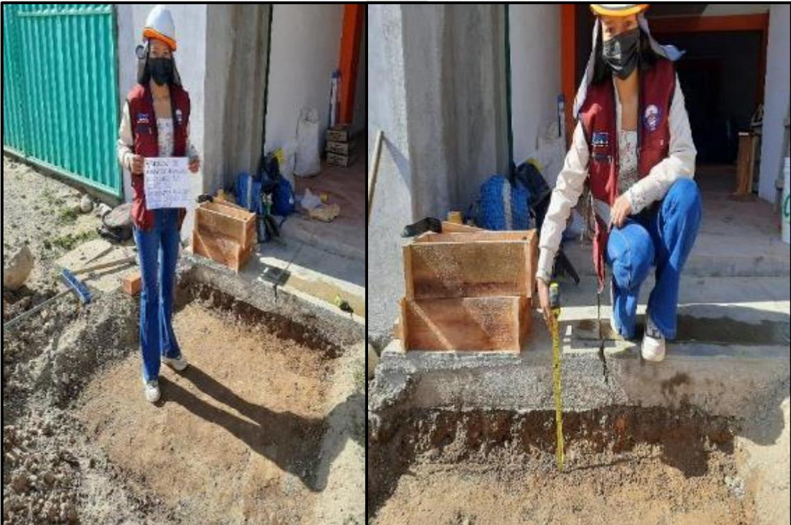
**Fotografía 85:** Terreno a nivel de base para el tramo de prueba de losa de pavimento rígido con una mezcla de concreto correspondiente al GE<sub>1</sub>.
