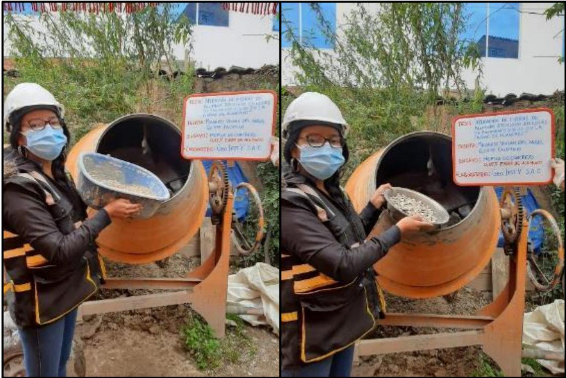
**Fotografía 60, Fotografía 61:** Vista de los agregados incorporados a la mezcla para la elaboración del concreto del GE<sub>3</sub>. Según NTP 339.183.
