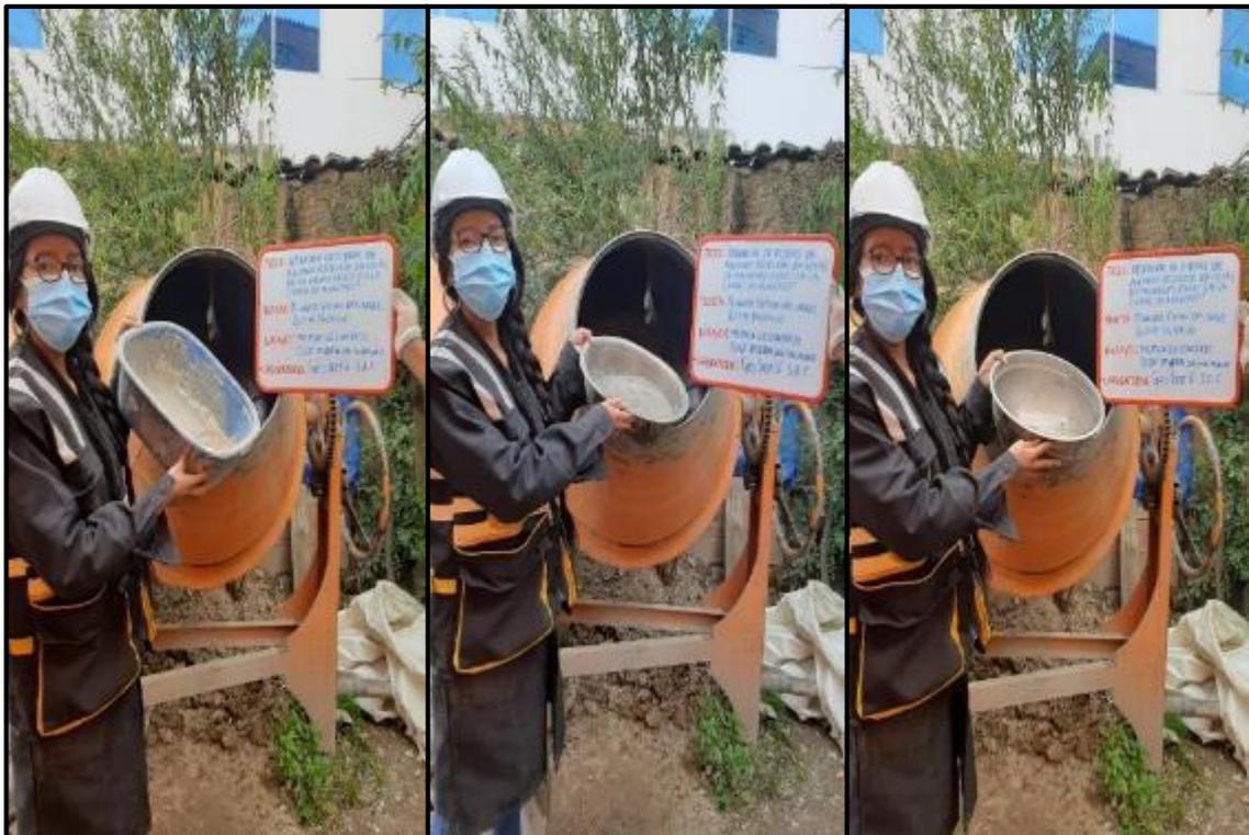
**Fotografía 74, Fotografía 75:** Incorporación de materiales tales como cemento, agua y fibra de aluminio reciclado para la elaboración del concreto del GE4. Según NTP 339.183.
