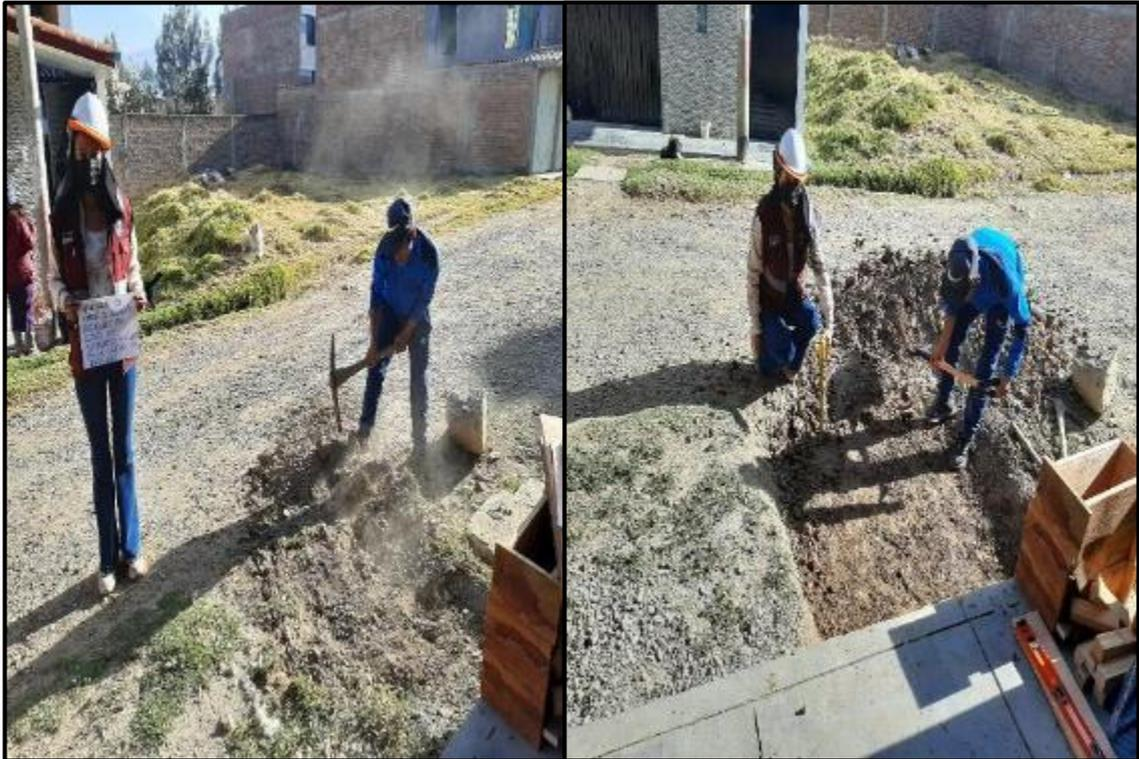
**Fotografía 84:** Excavación del terreno para el tramo de prueba de losa de pavimento rígido con una mezcla de concreto correspondiente al GE<sub>1</sub>.
