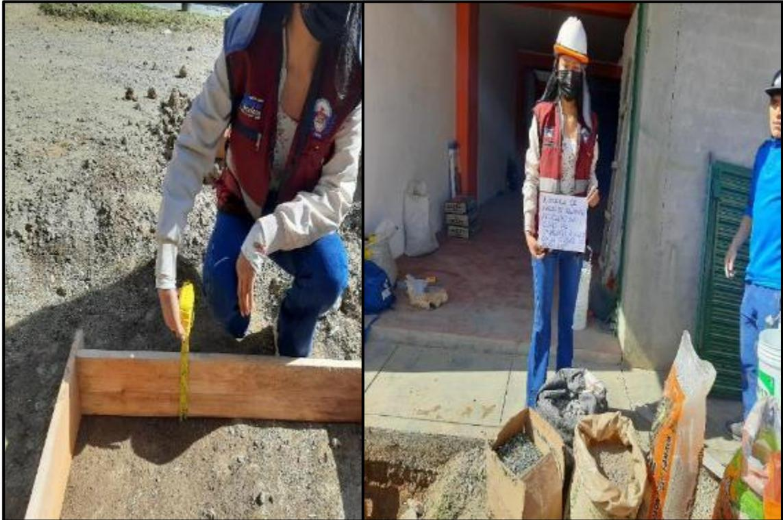
**Fotografía 86:** Encofrado e insumos para el tramo de prueba de losa de pavimento rígido con una mezcla de concreto correspondiente al GE<sub>1</sub>.
