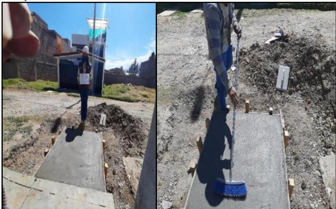
**Fotografía 89:** Vaciado de concreto y texturalizado en el tramo de prueba de losa de pavimento rígido con una mezcla de concreto correspondiente al GE<sub>1</sub>.
