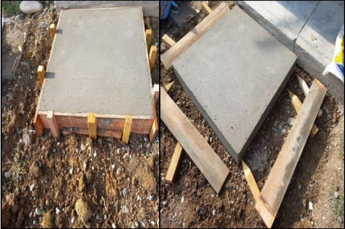
**Fotografía 90:** Desencofrado del tramo de prueba de losa de pavimento rígido con una mezcla de concreto correspondiente al GE<sub>1</sub>.
