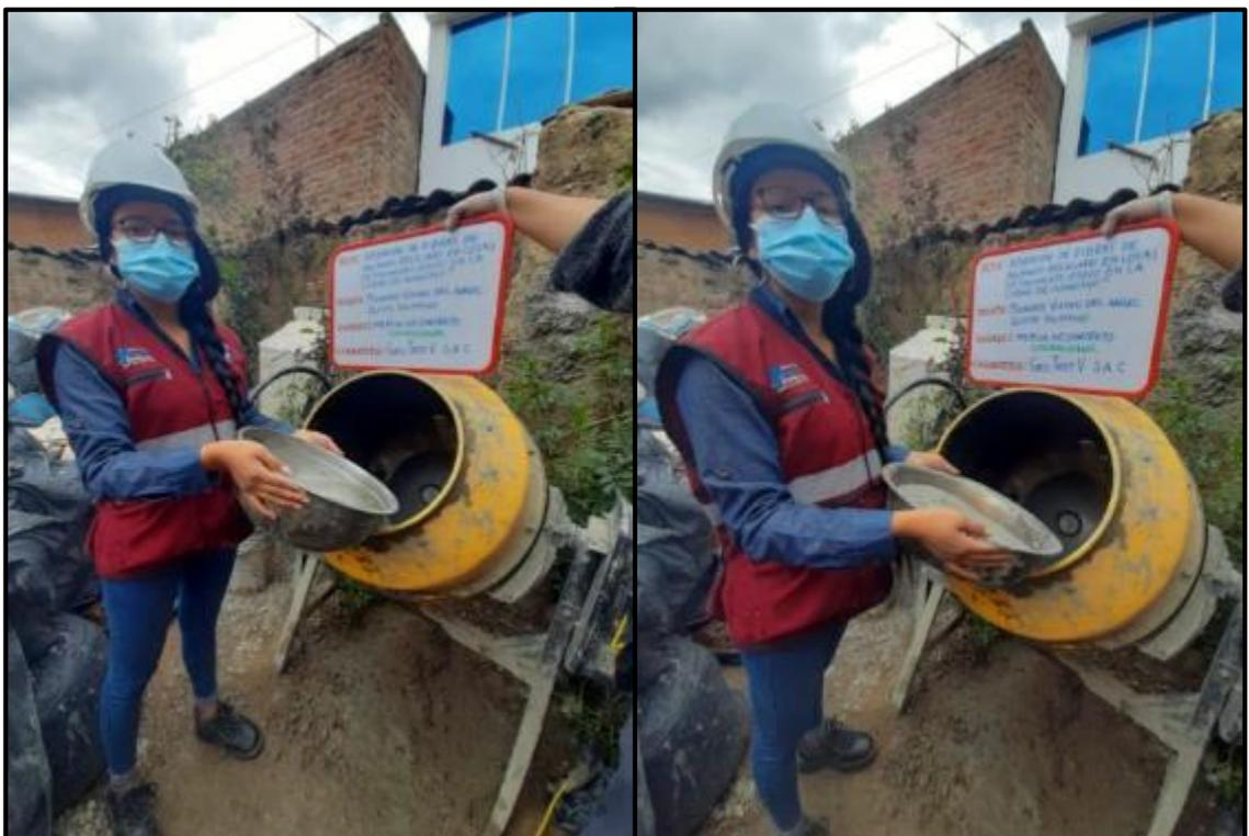
**Fotografía 26, Fotografía 27:** Incorporación de materiales tales como cemento y agua para la elaboración del concreto convencional. Según NTP 339.183.
