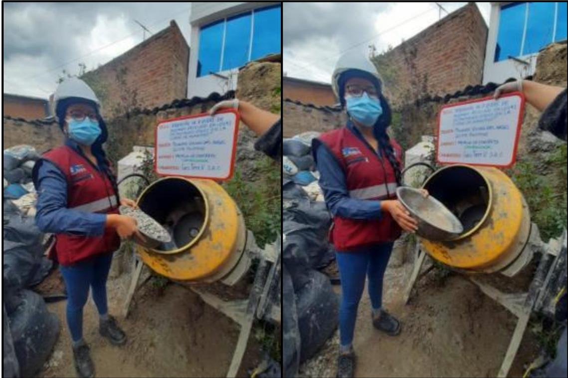
**Fotografía 24, Fotografía 25:** Vista de los agregados incorporados a la mezcla para la elaboración del concreto convencional. Según NTP 339.183.
