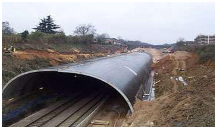
*Figura 14.* Túnel falso para disminuir el riesgo
