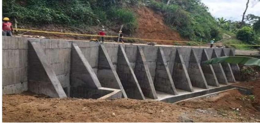
*Figura 77.* Muro de contención concreto armado
